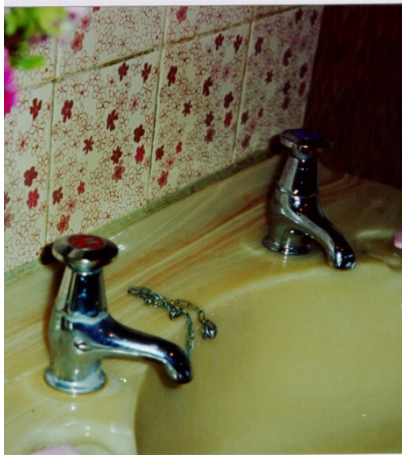
Kuva 2.4: Englantilaiset AUH-OIH-tyyppiset vesihanat. Tässä tapauksessa on helppo saada vettä. Sen sijaan kasvojen tai käsien pesu polttamatta tai paleluttamatta käsiään on toinen juttu – varsinkin, kun kuuma vesi ei aina ole pohjoismaista alle 40° C turvavettä ja vesitulppa on kadoksissa.
