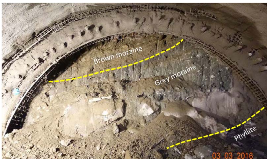
Figur 3: Stuff i løsmassetunnelen, ca. 10 meter fra påhugget.
