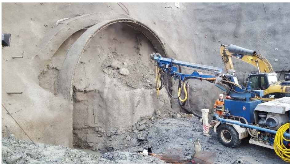
Figur 5: Etablering av midlertidig sprøytebetongportal
