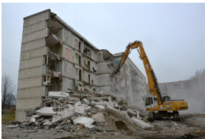
ATTĒLS 71. DAUDZDZĪVOKĻU ĒKAS RŪPNĪCAS IELĀ 7, UGĀLĒ DEMONTĀŽAS PROCESS 2019.GADĀ
