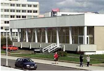
Robotron Kantine: Südwest Stream I zur Bierleitung?
