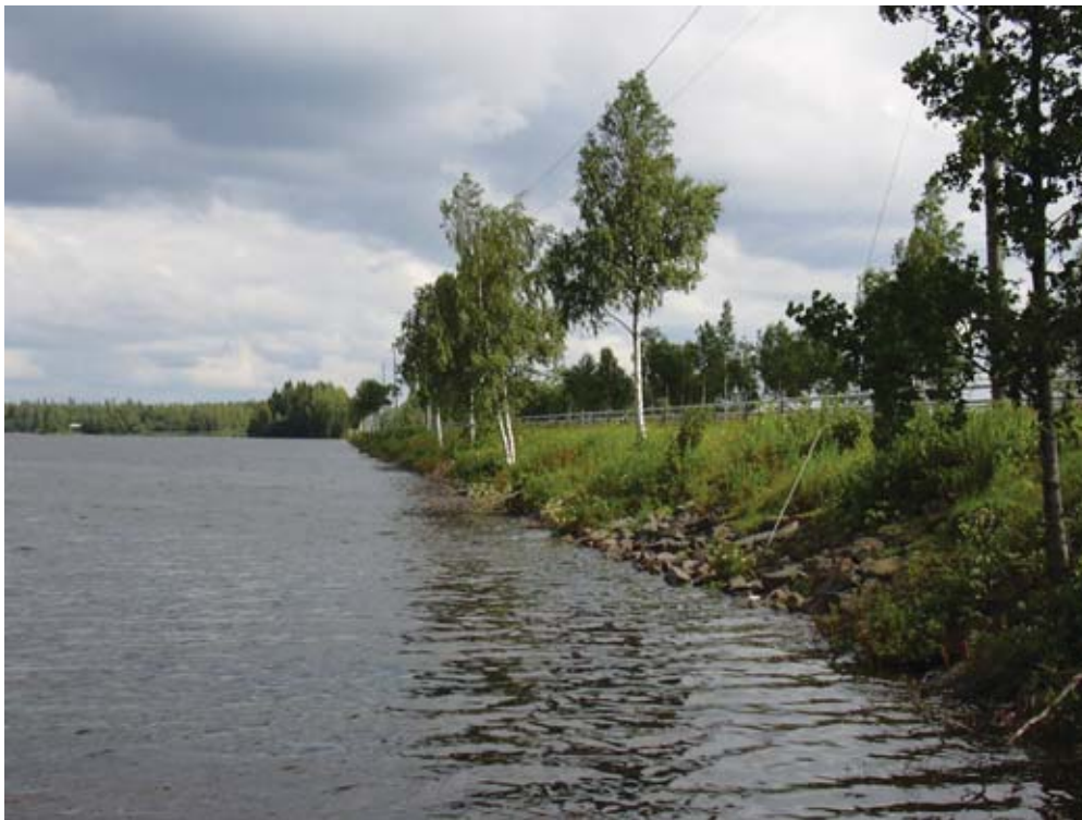
Figur 17: Vägbanken som stänger in åns mynningsområde och skapar Västerfjärdens sötvattenbassäng. Foto: Niklas Ojala
