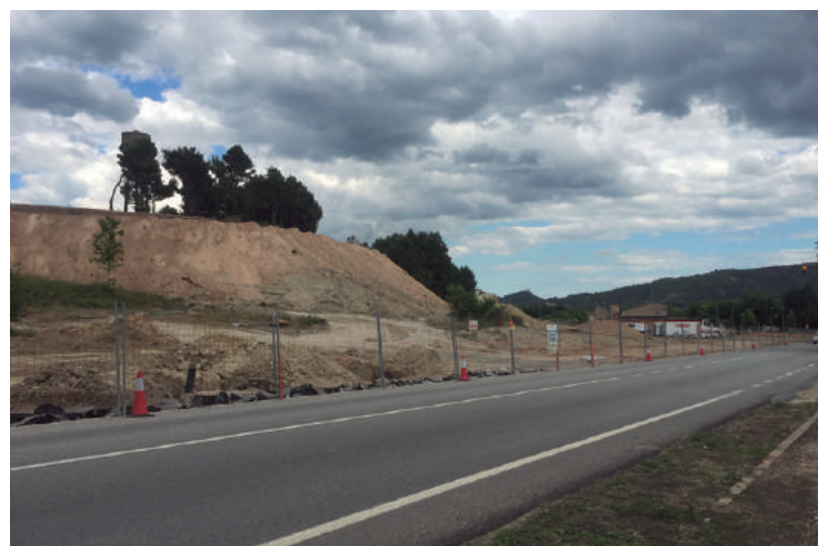
Les màquines ja treballen en l'adequació dels terrenys.
