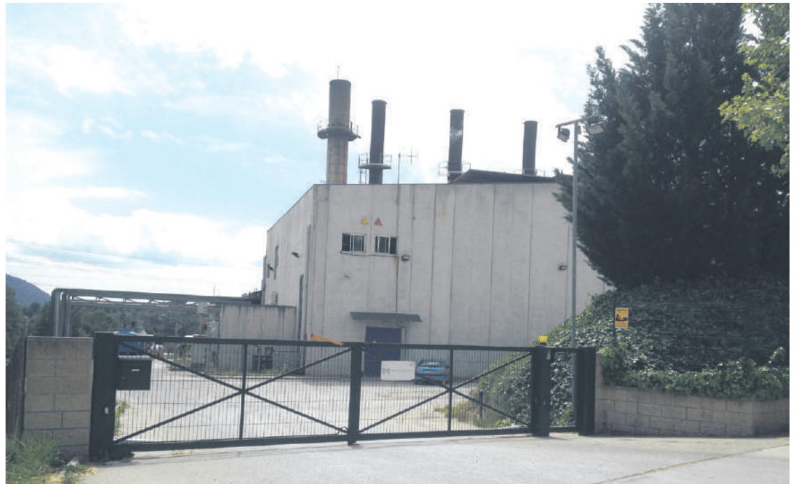
La planta de cogeneració de Rofeica Energia, al polígon Plans d'Àrau de la Pobla de Claramunt.
