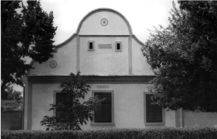
Оригинална кућа у којој је Пуџин рођен. Она је срушена након смрти мајке Олимпијаве и тек 1979. године обновљена, од кад је у надлежности Дома културе у Идвору.
