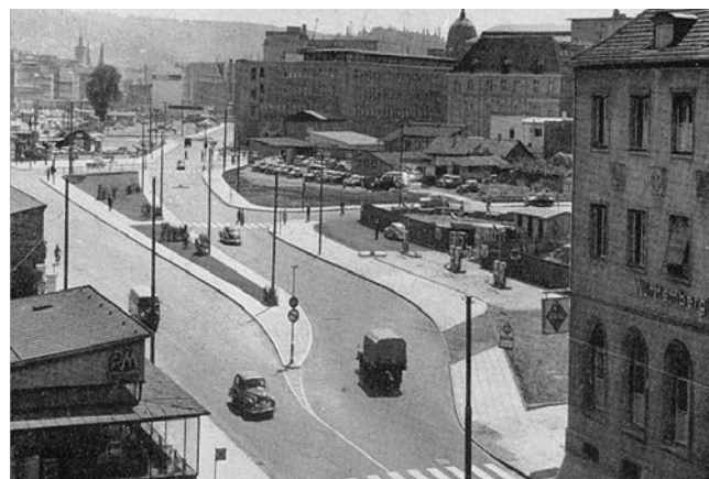
Bild 3: „geschickter Übergang von einer vorläufig noch beengten Zwischenstrecke zur Kreuzungsdurchfahrt“ (Korte, 1960) in Stuttgart | Foto: Tiefbauamt Stuttgart
