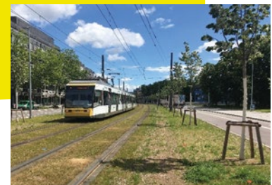
Bild 9: Kriegsstraße als Bundesstraße und als Teil der Kombilösung in Karlsruhe | Foto: Topp
