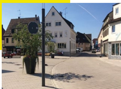
Bild 11: Ortsdurchfahrt Rudersberg 2011 (oben) und nach dem Umbau (2015) | Foto: Rudersberg
