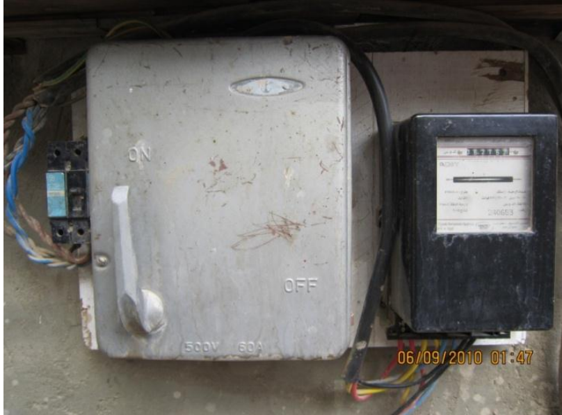
الشكل (4-54) تركيب عداد ساعة 3ph مع قاطع دورة 3ph مع مين سويج 3ph/60A .
