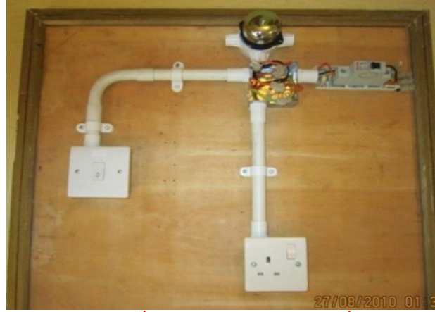
الشكل (4-26) ربط أسلاك دائرة الجرس والمأخذ الى العناصر الكهربائية
