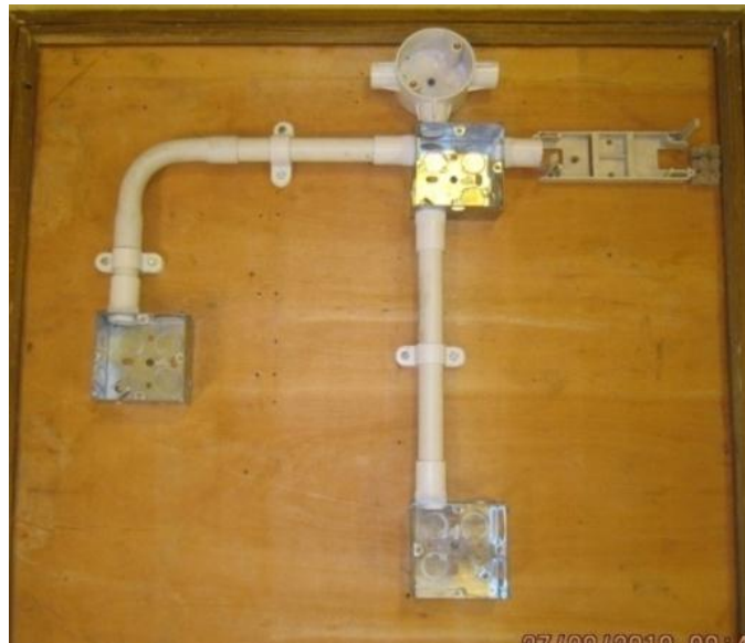
الشكل (4-24) تثبيت الانابيب البلاستيكية والصناديق لدائرة الجرس والمآخذ .
