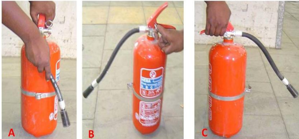
شكل ( 6 - 1 ) يوضح مراحل إستعمال مطفئة الحريق ، A - سحب الانبوب الطاح من موضعه B - سحب المسمار وإخراجه ، C - الضغط على المقبض وتوجيه الخرطوم بإتجاه الحريق .
