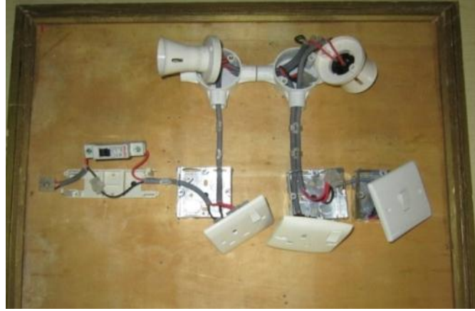
الشكل (4-36) توصيل نهايات الكيبلات الى العناصر الكهربائية
