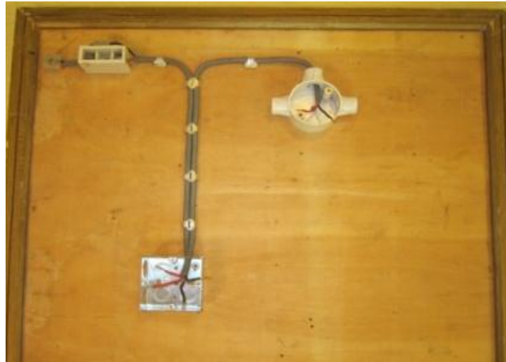
الشكل (4-16) تثبيت الكيبل الظاهري والصناديق وقاعدة المصهر على لوحة التدريب
