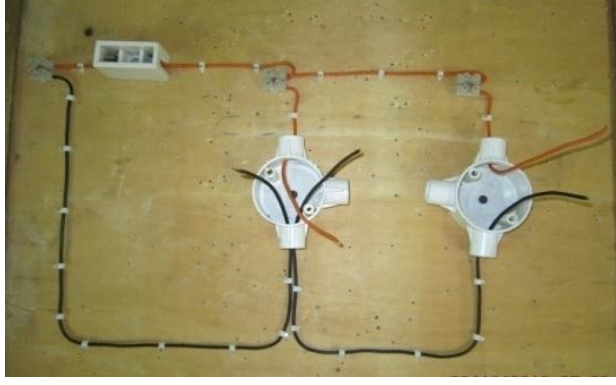
شكل (2-12) يوضح تثبيت الأسلاك بواسطة الكلبسات على اللوحة الخشبية .
