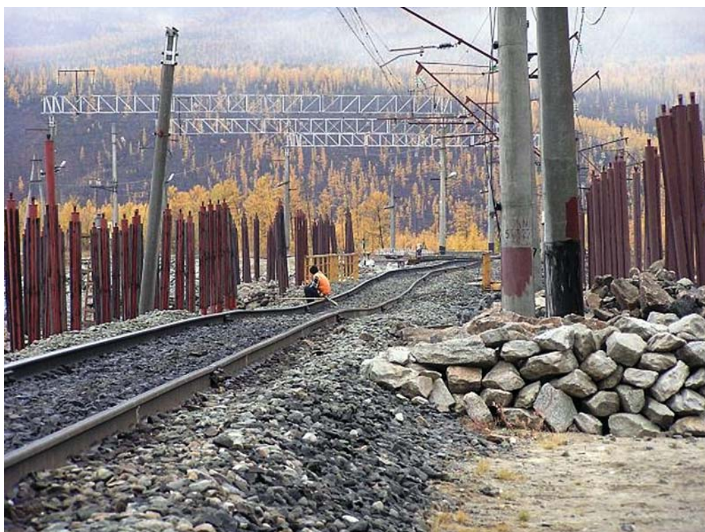
Рис. 9.21. Деформирование железнодорожных путей в результате деградации вечной мерзлоты (БАМ, станция Казанкан) [Лапердин, Качура, 2010].
