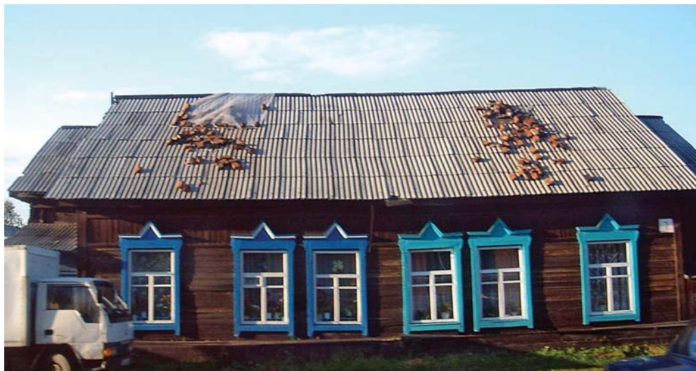
Рис. 9.10. Разрушение печных труб в г. Слюдянка, Култукское землетрясение 2008 г. (фото сотрудников ИЗК СО РАН) [Леви и др., 2009].
