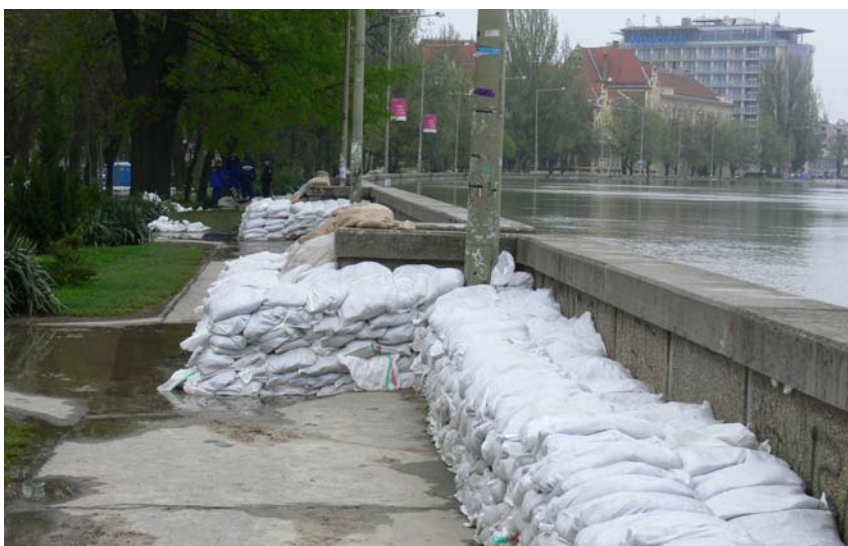
13-107. kép. Kulisszanyílások védelme 2006-ban Szegeden.
