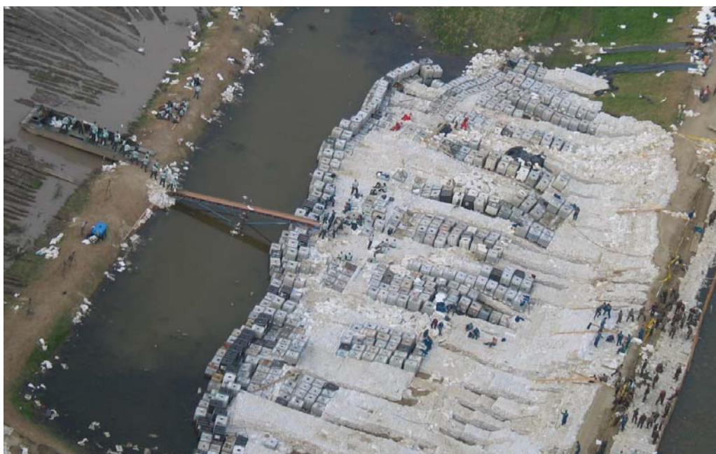
13-150. kép. Szállítószalag viszi át a víz felett az árvízvédelmi anyagot.
