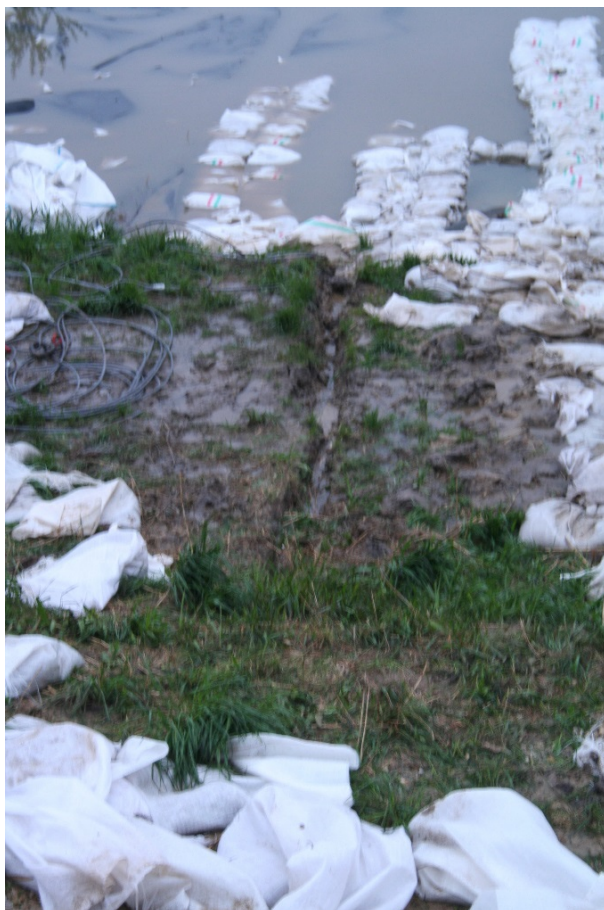
13-47. kép. Szivárgó vizek kivezetése a gátból.
