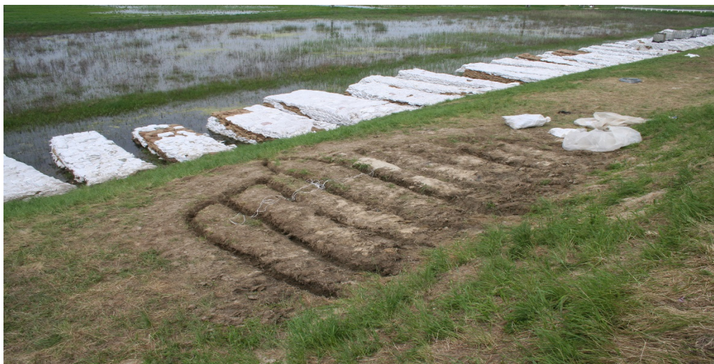
13-65. kép. A felszínt szárító folyókák, vízkivezetések.
