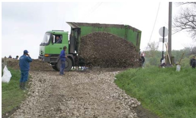
13-153. kép. Homokzsák átrakóhelyhez térkialakítás épül.
