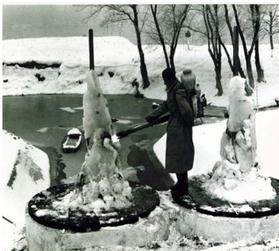
13-120. kép. Múrtárgy kezelő szerkezetének jégtelenítése.
