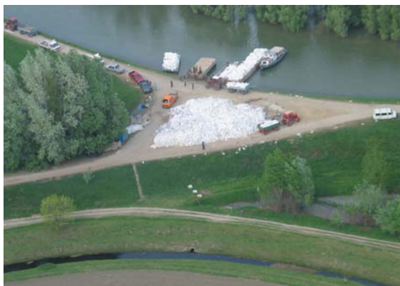
13-139. és 13-140. kép. Ideiglenes kikötők kialakítása árvízvédekezéskor.
