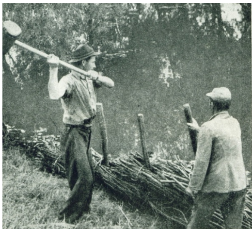
13-29. kép. Futó rózsesor készítése a víz színére.
