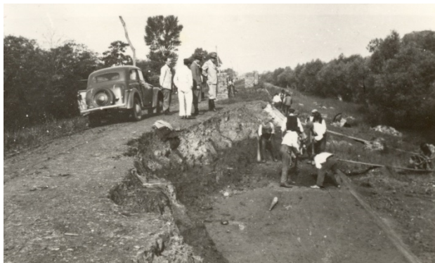
13-42. kép. Elhabolt rézsű helyreállítása 1940-ben Abádszalókon
