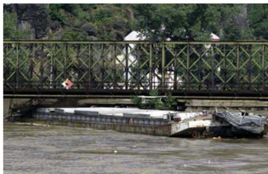
13-114. kép. Elszabadult hajó az Elbán 2002-ben beszorult a híd alá, nemcsak az acélszerkezetet, de a hídpillért is veszélyeztette.
