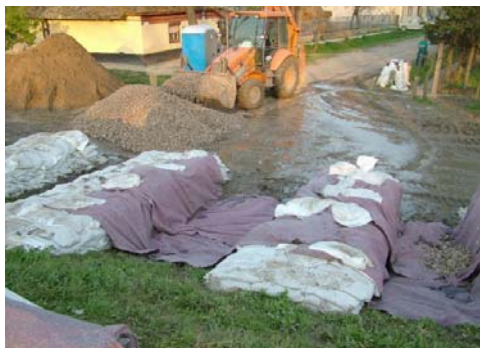
13-70. kép. Zúzottkő leterhelés készítése a kő alá helyezett geotextíliával lehet megakadályozni az altalajba történő benyomódást.
