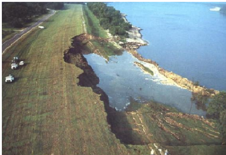
13-81. kép. Vízoldali suvadás az 1967. évi Mississipp-i árvíz után.
