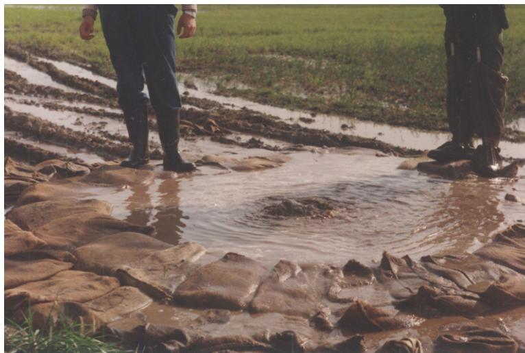
13-83. kép. Tiszasasi buzgár, közvetlenül a felfedezése után.
