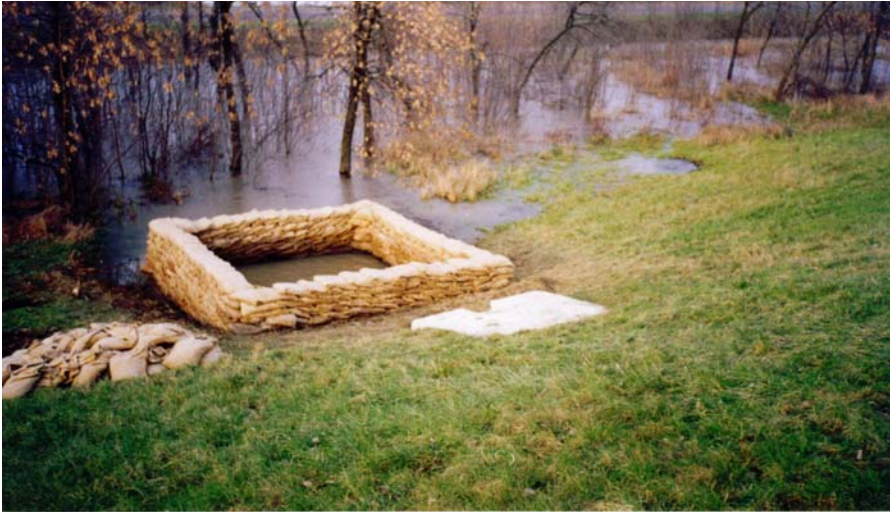
13-89. kép. Ez a buzgár elleni védekezés nem azért rossz, mert nem kerek, hanem azért, mert nem tart víznyomást. A vízszint meg-egyezik a háttér fakad-óvíz szintjével.
