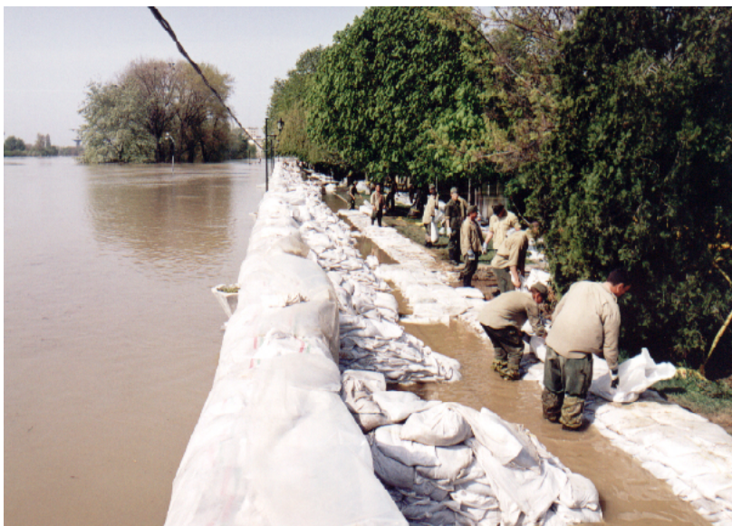
13-14. kép. Szolnok parti sétány parapetfal magasítása 2000-ben. A képhez tartozó keresztmetszeti ábra: 13-10.
