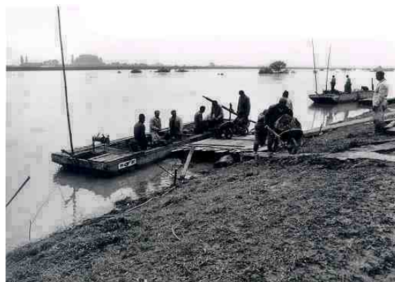
13-139. és 13-140. kép. Ideiglenes kikötők kialakítása árvízvédekezéskor.
