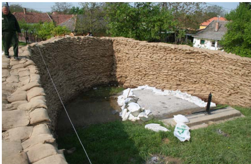
13-110. kép. Sárkányfarki zsilip bevédése a 2006. évi árvízkor
