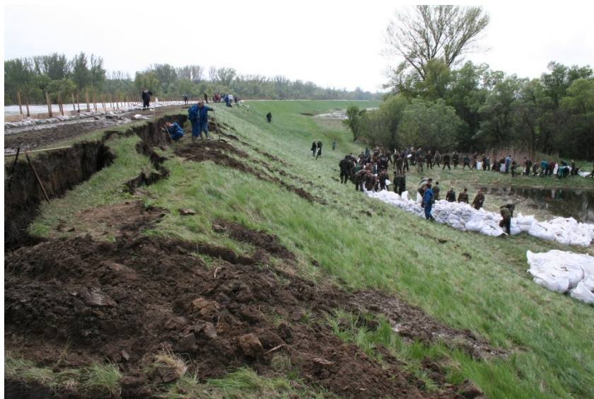
13-60. kép. Csongrád Nagyréti suvadásnál órák alatt kialakult egy méteres függőleges elmozdulás.
