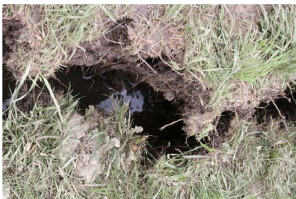
13-66. kép. A koronán a húzási repedésben azonnal megjelent a víz.
