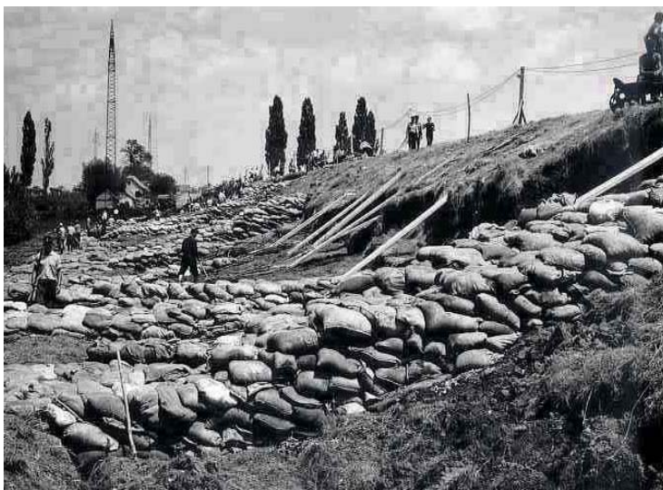
13-57. kép. Foki-híd alatti suvadás 1970 évi árvíznél.
