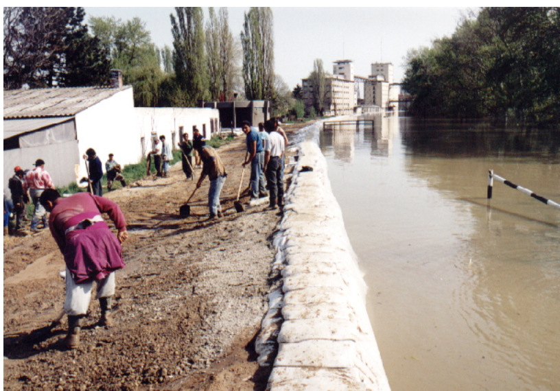
13-15. kép. Szolnok téglaházi szakasz parapetfal magasítás 2000-ben. A hozzá tartozó metszet a 13-11. ábra.
