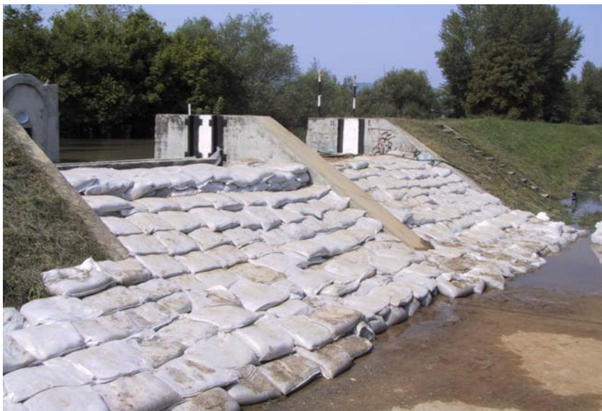
13-106. kép. Kulisszanyílás bevédése a Szentendrei-szigeten.
