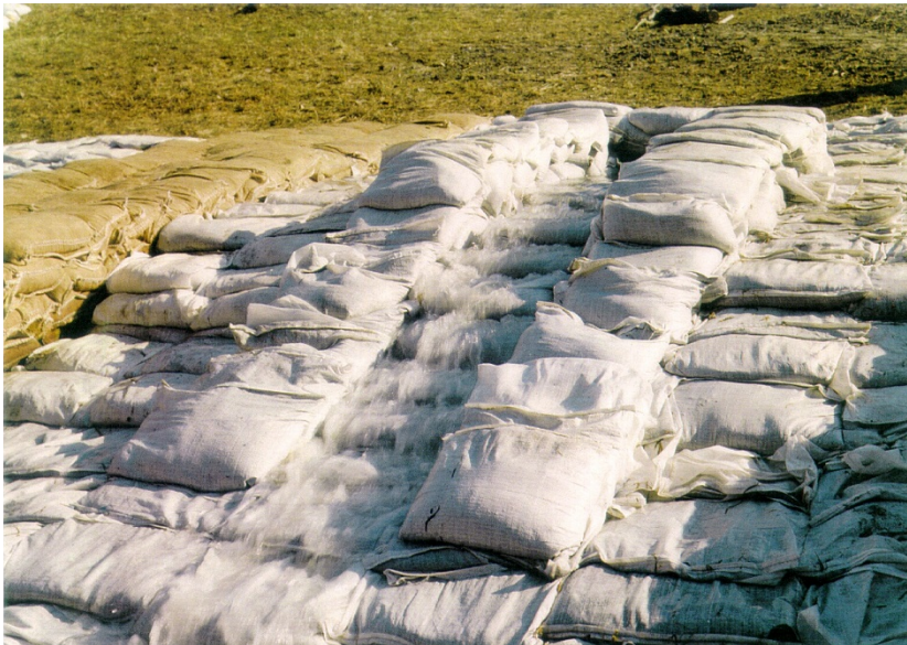
13-56. kép. Szolnok volt vasúti töltés „Niagara” csurgása.
