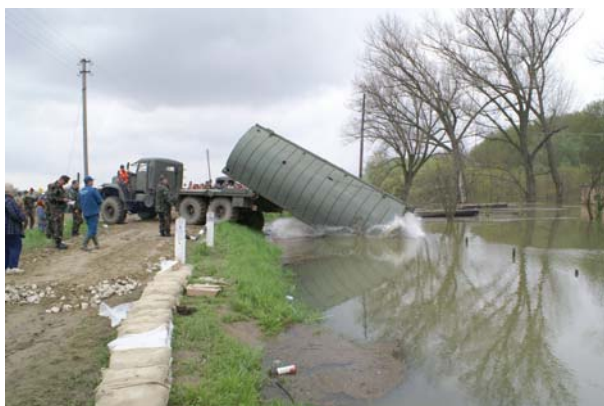
13-141. kép. Ponton vízre helyezése a 2006. évi árvíznél.
