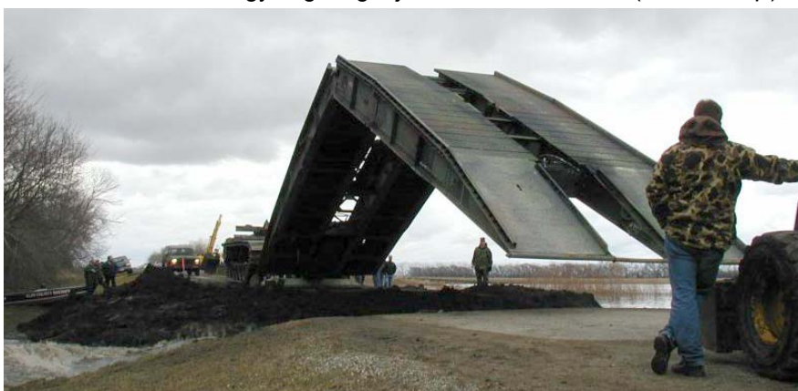
13-147. kép. Hídvetővel gyorsan helyreállítható a forgalom az elmosott gáton (Fargo árvíz 2001), és a gátszakadás elzárás is mehet oldalra billentéssel.
