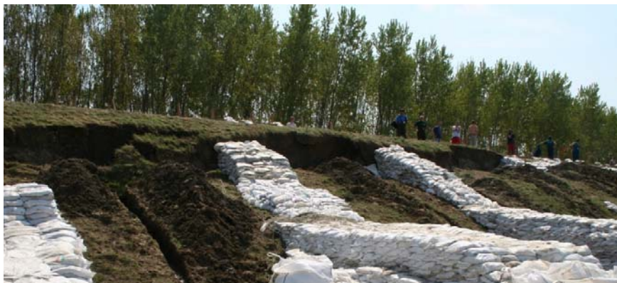
13-74. kép. Szabadon álló földfal megtámasztása a szelevényi suvadásnál.
