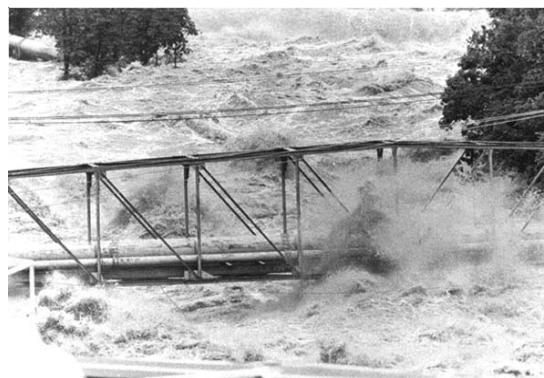
13-115. kép. A víz nyomására a híd leugorhat a sarukról, el is viheti a híd a víz.
