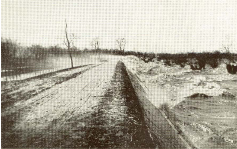
13-23. kép. A töltés koronán is átcsapó hullámok az 1940. évi áprilisi orkánál. A vízszint a téglaburkolat hullámtörőjéig ért.
