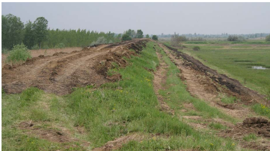
13-4. kép. Töltésfejelés egy lokalizációs gáton a 2006 évi árvízvédekezéskor. Valószínűleg a humusztalanítás elmaradt. A helyszínre szállított föld túl nagy rögöket tartalmazott.
