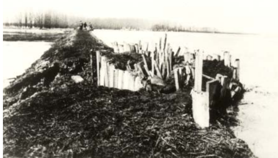
13-129. kép. Elfogott gátszakadás a Sebes-Körös melletti ún. trianoni gáton 1940. III. 17.
