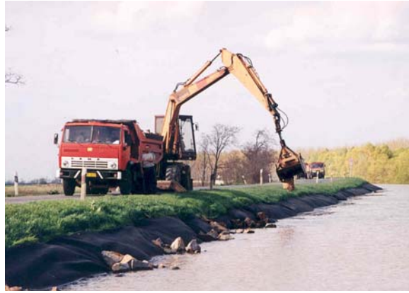
13-35. kép. Hullámvédelem geotextília terítése kő leterheléssel.
