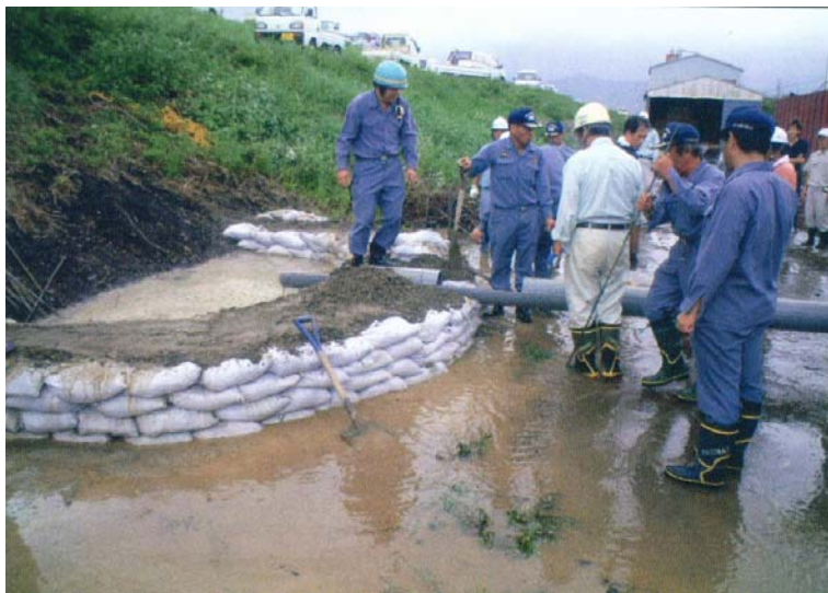
13-97. kép. Buzgár elleni védelem készül egy japán árvízvédekezésnél. A túlfolyó vizet csövön vezetik el.
