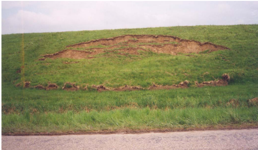
13-62. kép. A Szamos fenntartótöltés suvadása szemből.
