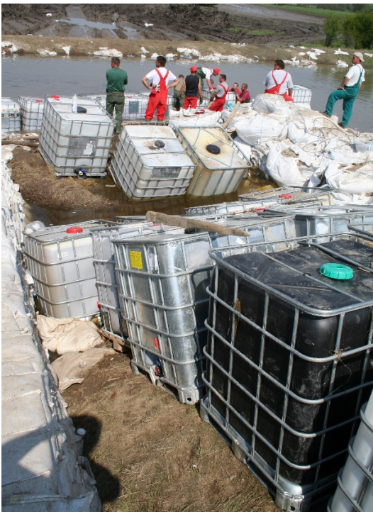
13-76. kép. Ballonok az Istvánházi suvadás bordái között, rendezett védekezés.
