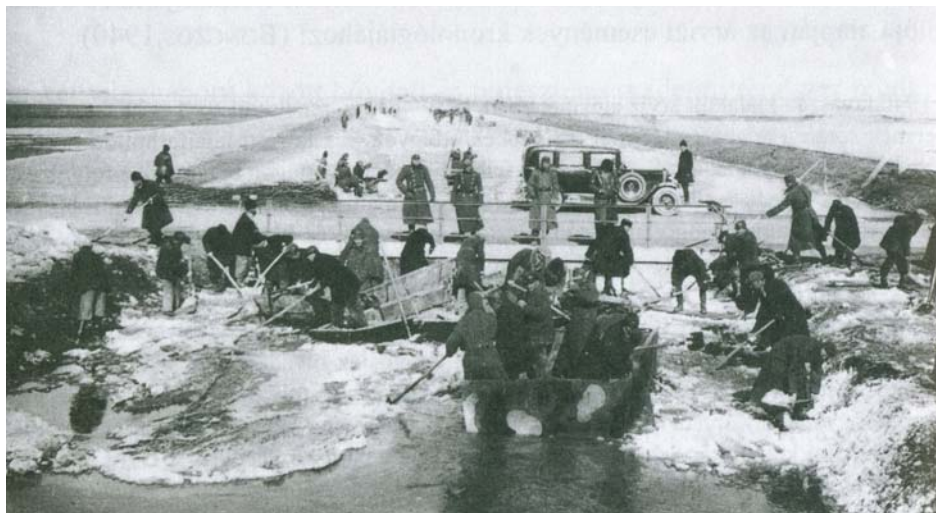
13-124. kép. Jégvédekezés kézi szerszámokkal az Algyői-főcsatornán 1940-ben.
