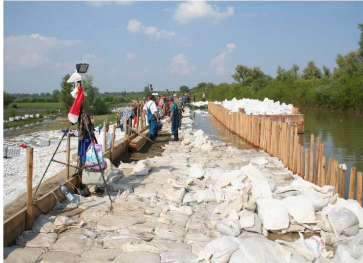
13-69. kép. Vízoldali védekezés oldalsó megtámasztással.
