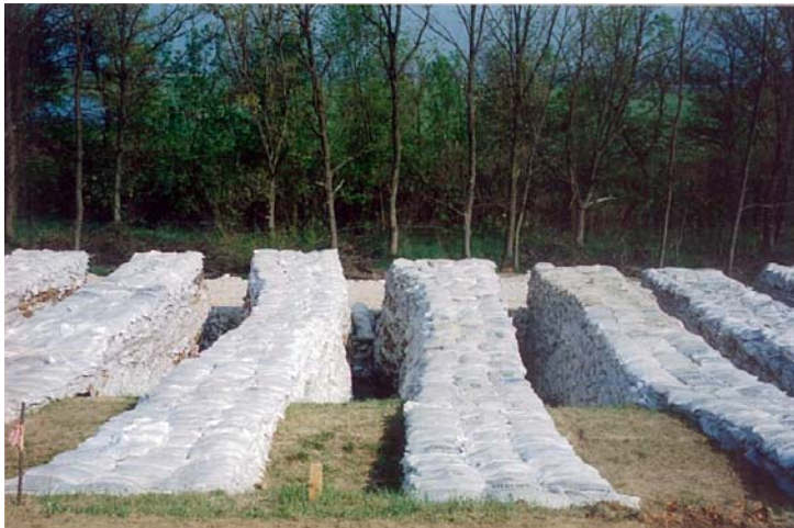
13-70. kép. Bordás megtámasztás homokzsákból.
