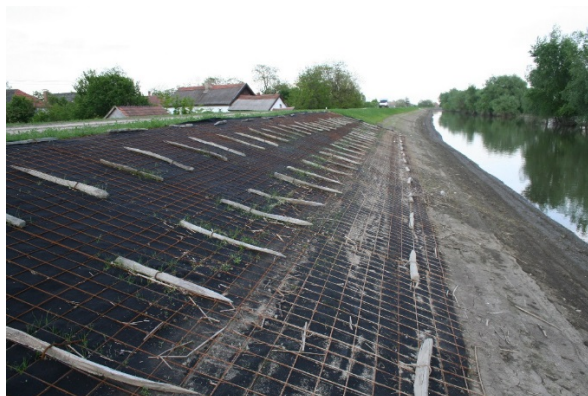
13-39. kép. Lehetséges, hogy a jövő évtizedek hullámzás elleni védelme a geotextília lesz, hegesztett hálóval lefogva és tuskékkal a talajhoz rögzítve.
