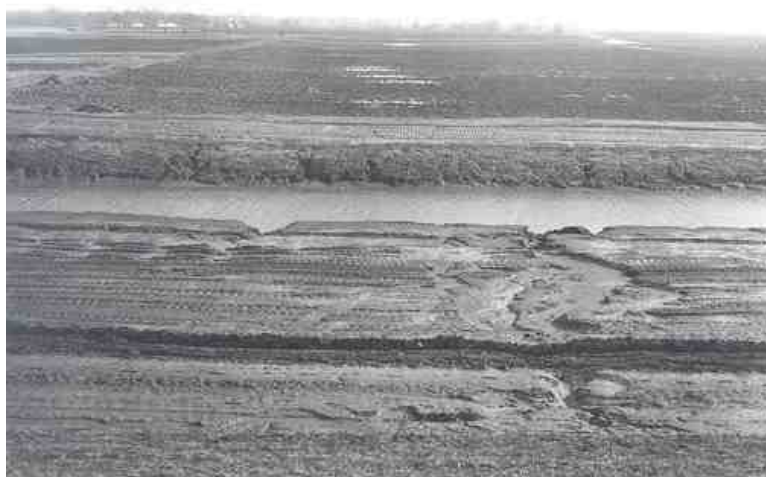
13-53. kép. Csurgás egy frissen elkészült gát mentett oldalán.
