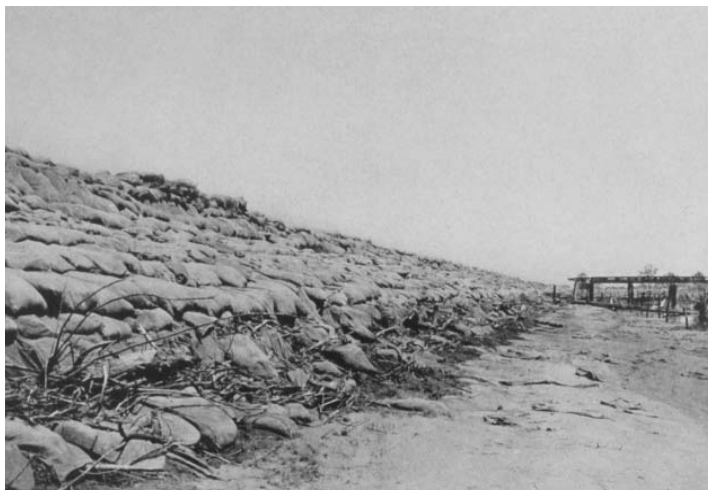
13-32. kép. A teljes vízoldali rézsű hullámvédelme homokzsákkal a Mississippi mellett 1912-ben.
