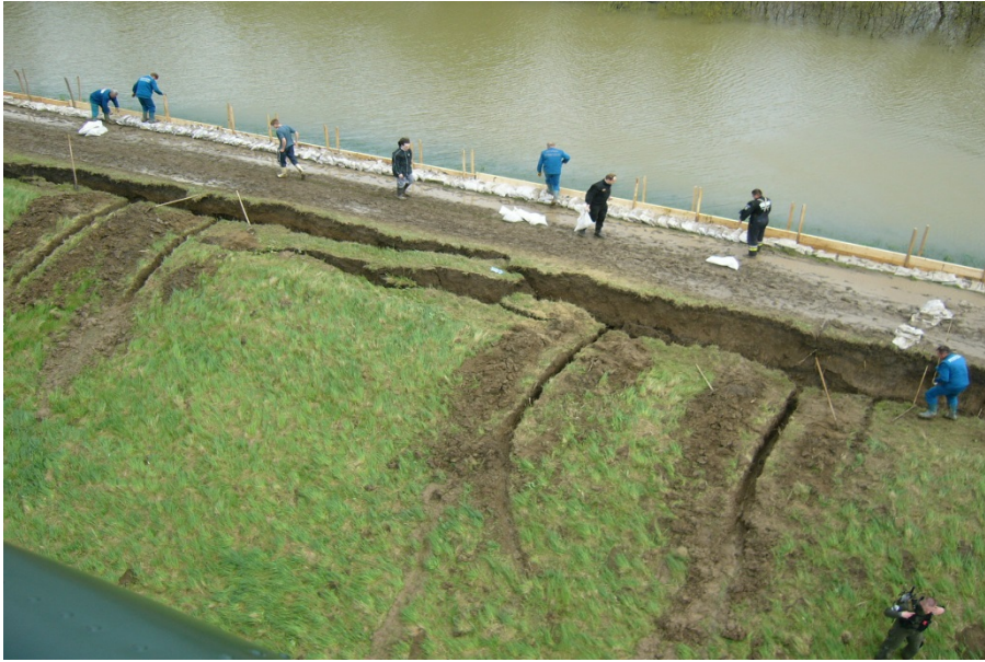
13-67. kép. Vízkivezető szivárgó csökkenti a terhelést a Csongrád nagyréti suvadásnál.
