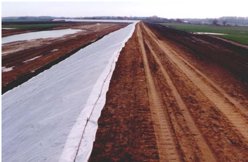
13-26. kép. Az épülő Kisdel-tározó ideiglenes hullámvédelme.
