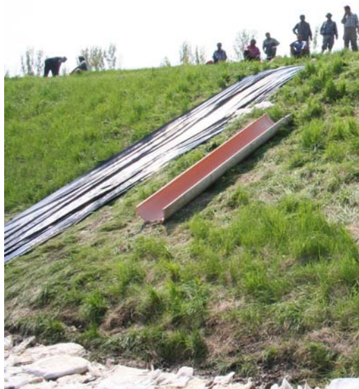
13-151. kép. Műanyag félcső és fólia segíti az árvízvédelmi anyag mozgatását a rézsún.
