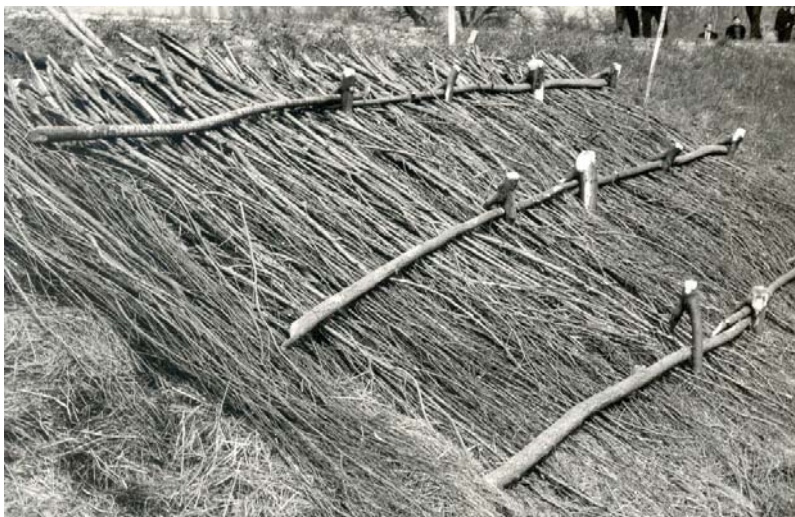
13-28. kép. Hullámvédő rózse fekvőmű (fekvő rózsepokróc) egy árvízvédelmi gyakorlaton. A rózse alatti szalma (a korabeli szűrőszövet) a talaj erózióját akadályozta meg.
