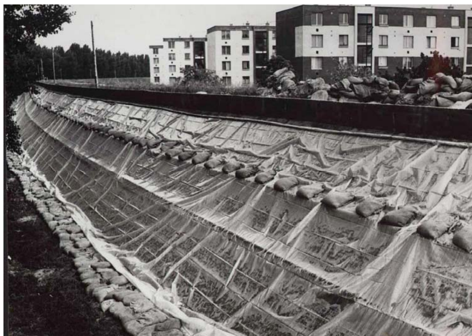
13-40. kép. Téglaburkolatú rézsű megelőző hullámvédelme, Szeged 1970.
