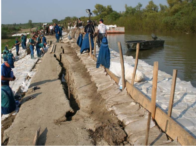
13-73. kép. A korona elvékonyodása a folyamatosan hátrarágódó suvadásnál.
