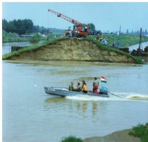
13-132. kép. Gátszakadásnál kialakuló függőleges földfal az 1980. évi Berettyó bal parti és Kettős-körös jobb parti gátszakadásoknál.
