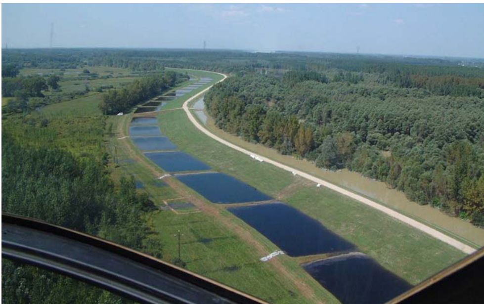
13-45. kép. A kavics altalaj fakadó vize tölti fel a mentett oldali ellennyomó medencéket a Szigetközben. A kavics altalaj miatt a víz saját maga alakítja ki ellennyomását, védelmét.
