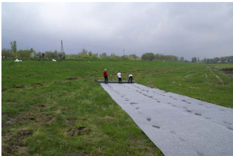
13-64. kép. Geotextília elválasztó, vízáteresztő réteg terítése, alapozás az árvízvédekezési beavatkozáshoz.
