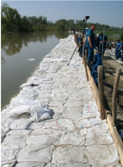
13-68. kép. A korona kiszélesítése a vízoldal felé homokzsákokkal
