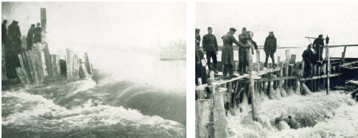
13-130. kép. Töltéscsont védelme és a gátszakadás bezárása a Sámson-apátfalvi-csatorna szakadásánál 1940-ben.
