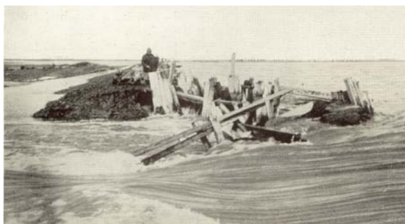
13-129. kép. Elfogott gátszakadás a Sebes-Körös melletti ún. trianoni gáton 1940. III. 17.
