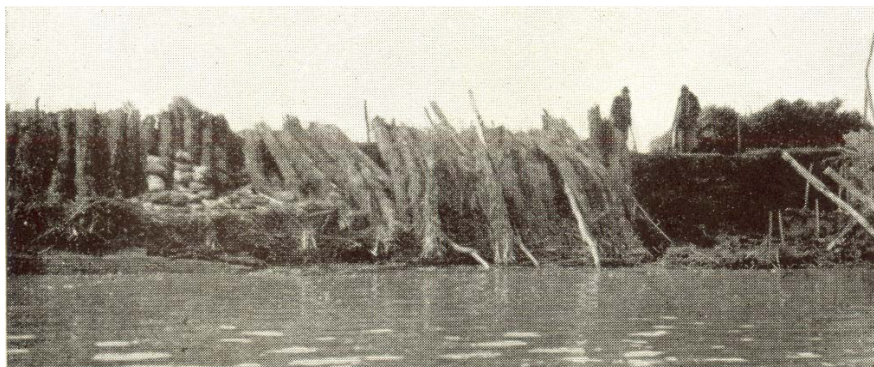
13-41. kép. Elhabolt rézsűjű gátat rőzsekévék belógatásával próbáltak megóvni a gátszakadástól.
