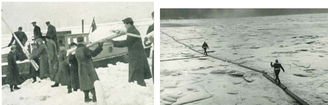
13-125. kép. Jégrobbantás eszközeinek telepítése hajóra és a jégfelületre.
