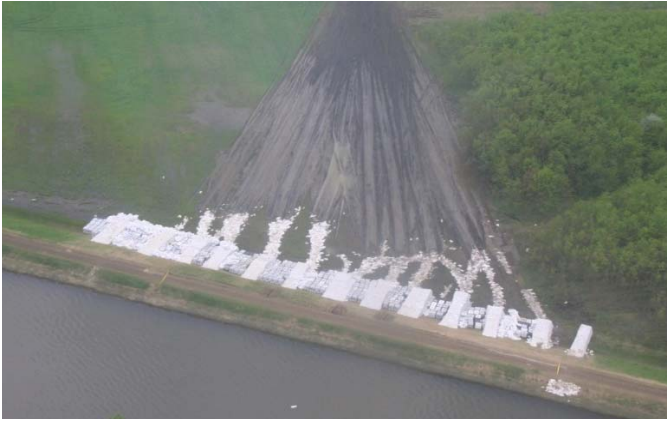
13-76. kép. Ballonok az Istvánházi suvadás bordái között, rendezett védekezés.
