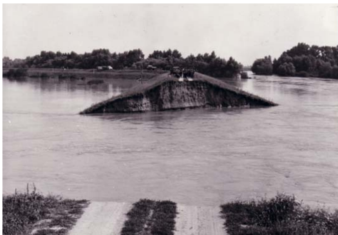
13-132. kép. Gátszakadásnál kialakuló függőleges földfal az 1980. évi Berettyó bal parti és Kettős-körös jobb parti gátszakadásoknál.
