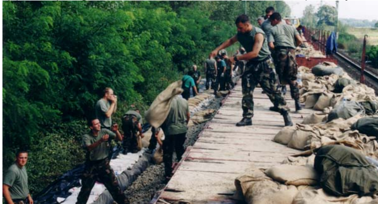
13-111. kép. Vasúti pálya védelme a Komárom – Almásfüzitő szakaszon. Azon kevés helyek közé tartozik, ahova a védelmi anyagot vasúton célszerű szállítani.
