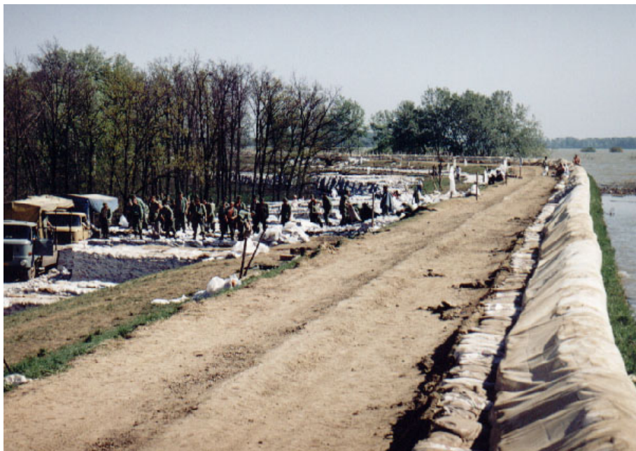
13-8. kép. Homokzsákból készült nyúlgát fóliával védve.
