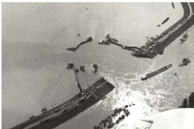
13-133. kép. Hosszúfoki gátszakadás bezárása acél szádlemezekkel 1980-ban.
