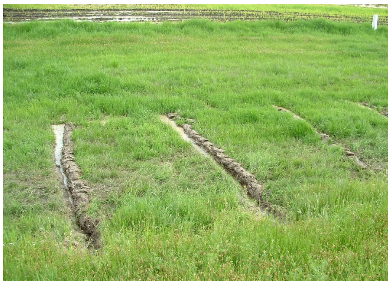
13-49. kép. A szivárgó vizek kieresztése a gyökérszóna átvágásával.
