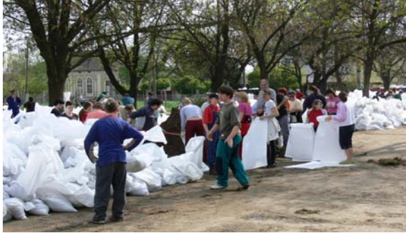
13-135. kép. Zsáktöltés a településen szabadtéren és fagyos időben fedett helyen.
