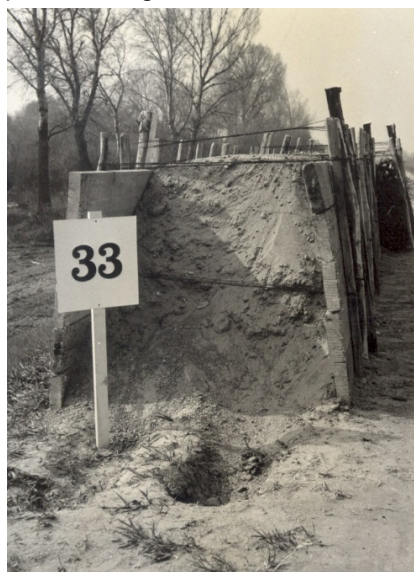
13-12. kép. Jászolgát palló fallal egy árvízvédelmi gyakorlaton.
