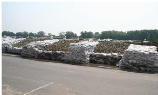
13-72. kép. Bordás megtámasztások köze zúzottkővel feltöltve Szentendrén (kőszekrény).
