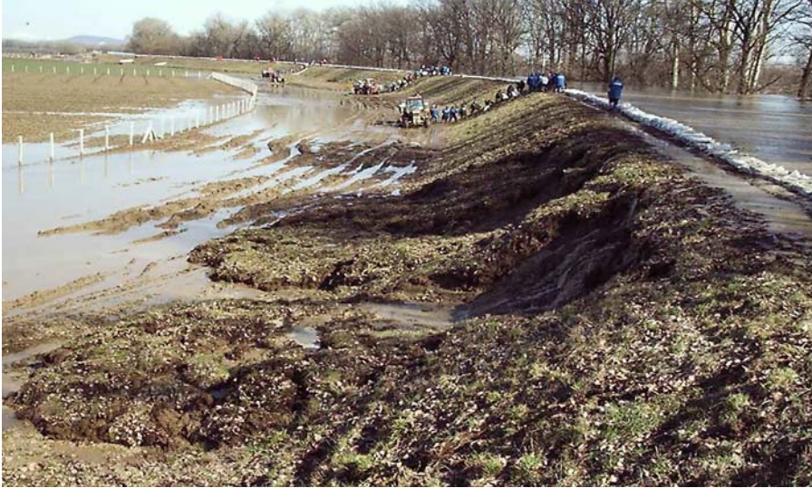
13-58. kép. Tarpai suvadás 2001-ben. Puha telített talajú rézsú lefolyt a töltéslábnál és ott legyezőszerűen szétterült.
