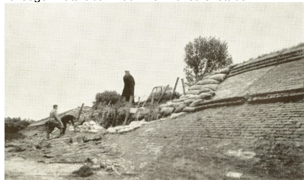
13-25. kép. 1940. áprilisi orkán hatása a téglarézsűburkolatra Tiszaderzsnél. Jól azonosíthatóak a téglaburkolat több sorban beépített hullámtörői.
