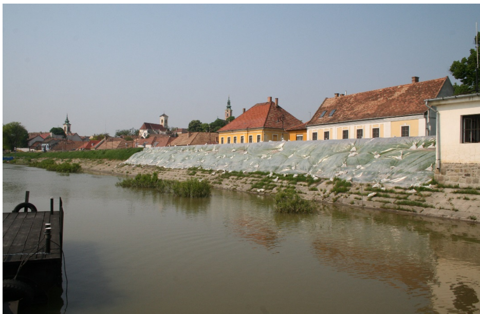
13-50. kép. A szivárgó vizek ellen lefóliázott vízoldali burkolat Szentendrén. A fólia nem hatékony szivárgás gátlás, mert nem tapadt neki a rézsűnek.
