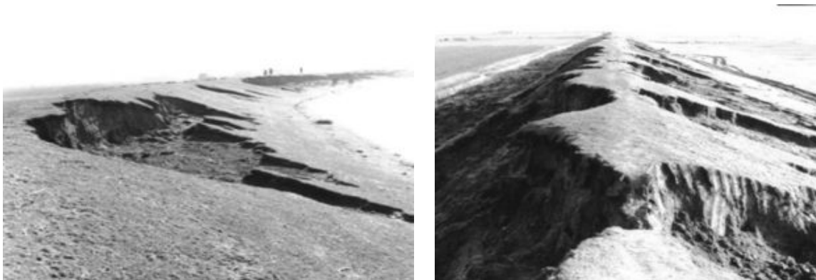
13-22. kép. Töltésrészsű elhabolása a vízoldalon (bal oldali ábra) és mindkét oldalon (jobb oldali ábra) az átcsapó hullámok hatására.
