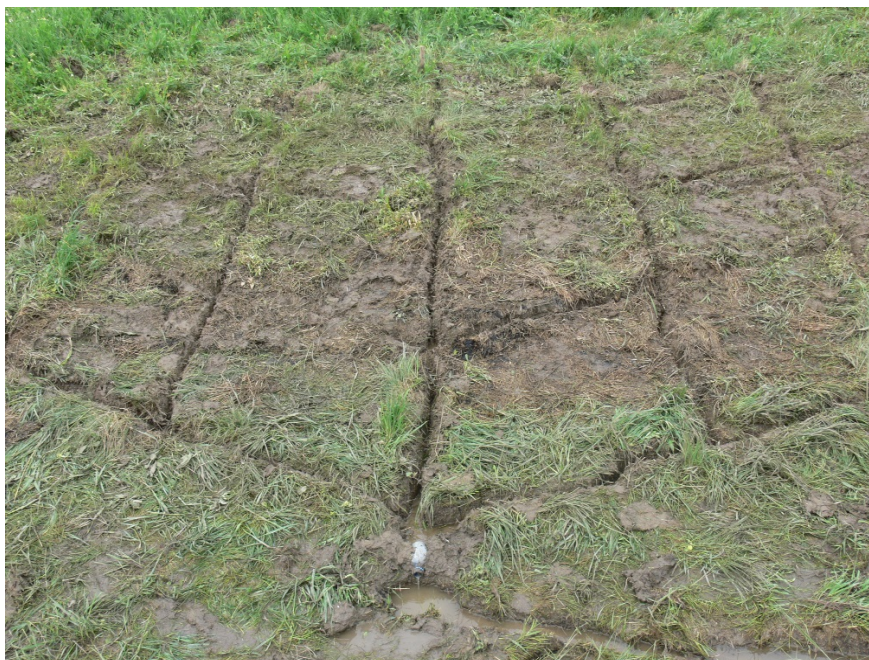
13-46. kép. Egy megoldás az átszivárgó víznek a töltéstestből való kivezetésére kis vízhozam esetén. Ez a módszer 1-2 nap alatt ki tudja szárítani a töltés felső részét.
