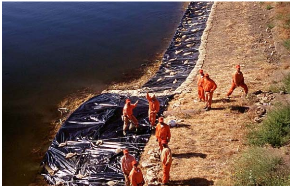
13-36. kép. Hullámvédelem fóliával, Kalifornia 2001. A fólia leterhelése belógatott homokzsákokkal.
