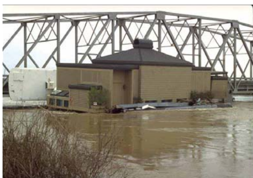
13-112. kép. A hidaknak ütköző úszó hordalék jelentős vízszintes erővel hat a hídszerkezetre.
