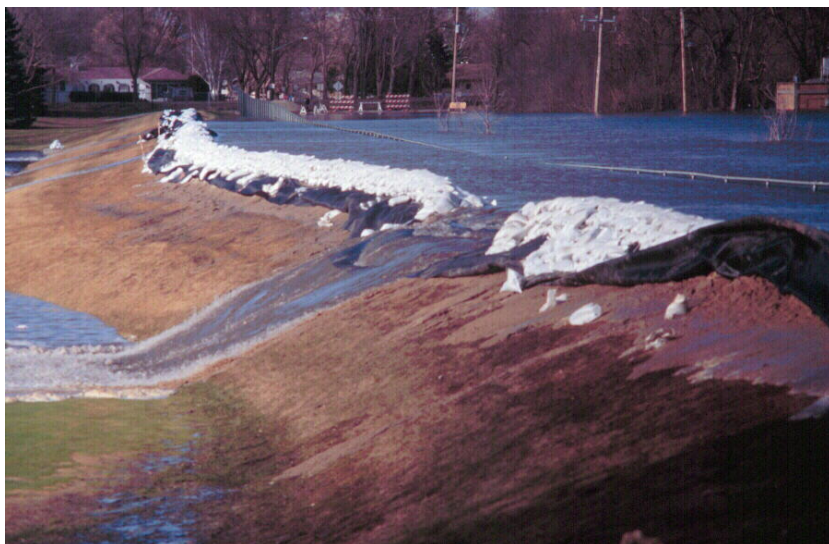
13-5. kép. Rossz helyre, a mentett oldalra épített nyúlgát. Ha a vízoldalra rakták volna, a közlekedést és a védekezést is fenn lehetett volna tartani. Így gátszakadáshoz vezetett.
