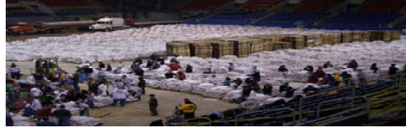
13-135. kép. Zsáktöltés a településen szabadtéren és fagyos időben fedett helyen.
