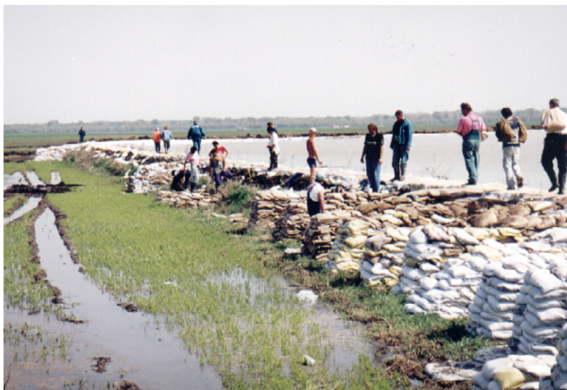
13-17. kép. Tiszajenő-Vezseny magasparti védekezés. A hozzá tartozó metszet a 13-12. ábra.
