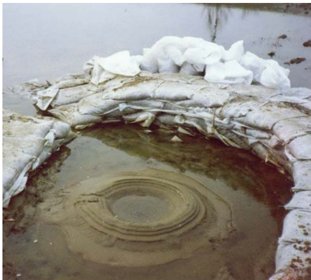
18-98. kép. Az 1998. évi dombrádi buzgár körülzárása és a kimosott anyag kúpja a vízszint csökkenése után.
