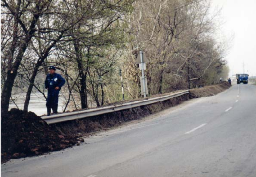
13-18. kép. A földből készült nyúlgát ráépült az útra és a védőkorlátra a Martfű feletti magasparton. A fényképhez tartozó metszet a 13-13. ábra.
