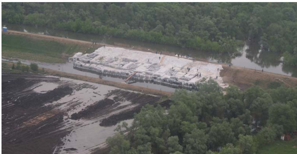
13-149. kép. A Csongrád-Nagyréti suvadásnál a PTSZ-ek úgy összezárták a területet, hogy a kép bal alsó sarokban látható dorongút építése vált szükségessé.
