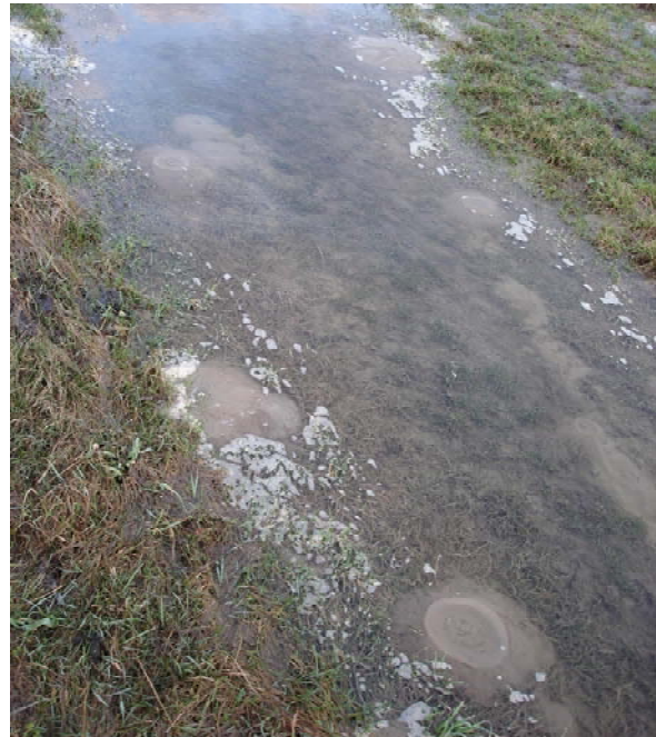
13-88. kép. Buzgár csoport ellen a védekezés a jelenségek összevonásával, szorítógáttal.
