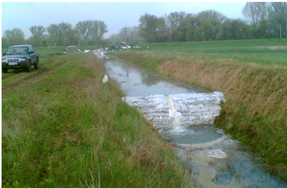
13-109. kép. Ellennyomó medence kialakítása szorítógáttal a műtárgyhoz vezető csatornában.
