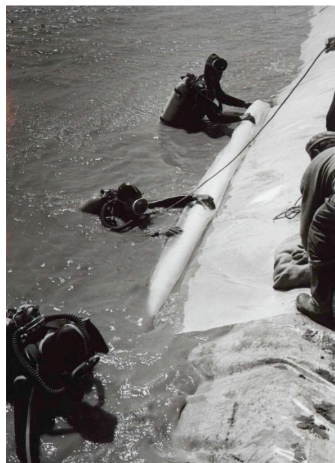
13-55. kép. Csurgás befolyó nyílásának műanyag fóliával való leterítése az 1970. évi Tisza árvíznél
