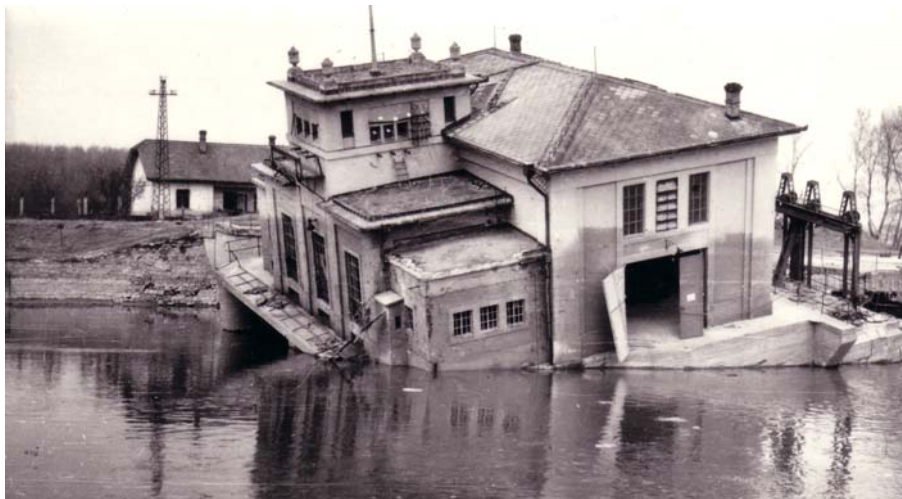
13-108. kép. Gátszakadás az 1956. évi árvíznél a Tassi zsilip mellett. A Soroksári Duna-ágból kifolyó víz alámosta a zsilipet is. A műtárgynak olyan erős vasbeton alaplemeze volt, hogy a helyreállításnál felmerült a visszabillentés kérdése.
