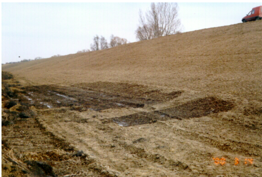
13-44. kép. A szivárgó víz megjelenése a Kettős-Körös jobb parti töltésén.
