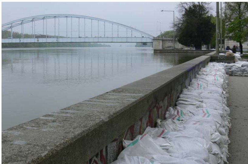
13-104. kép. A szegedi partfal megtámasztása 2006-ban.
