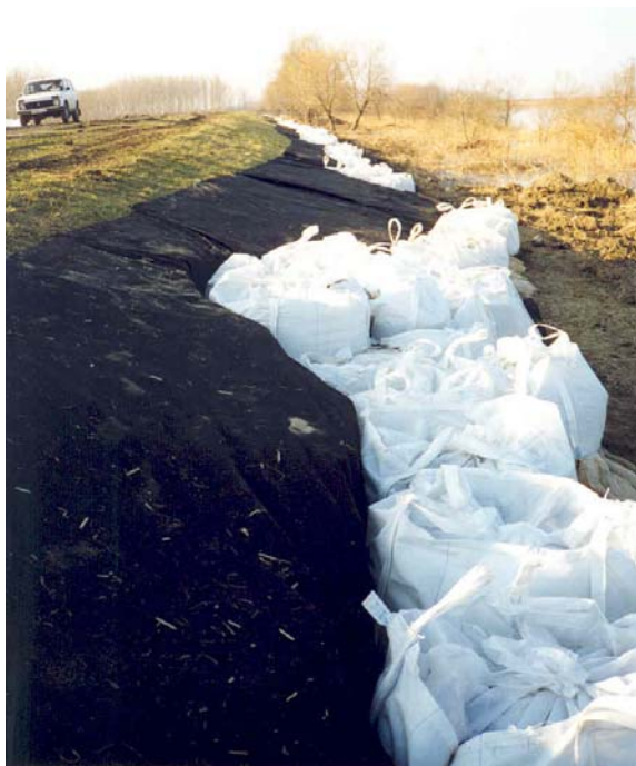
13-33. kép. Elhabolt rézsű hullámvédelme geotextíliára helyezett konténerzsákokkal Tiszanánánál.
