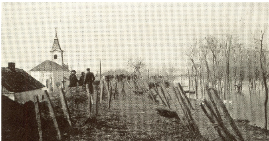
13-27. kép. Több szintben károsodott földrészsún Tisza-sülynél az 1940. április 6-8. közötti szélvihar hatására. A hullámszás a koronát is megbontotta.
