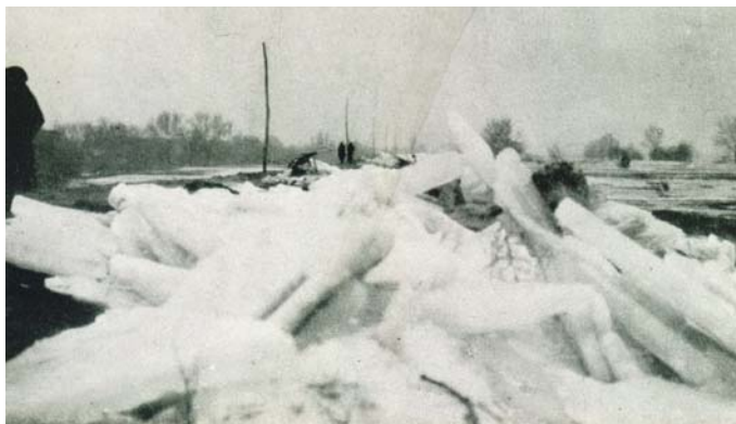
13-123. kép. Az árvízvédelmi gát vízoldalán feltorlódtott jégtáblák az 1941. évi dunai jeges árhullámnál.
