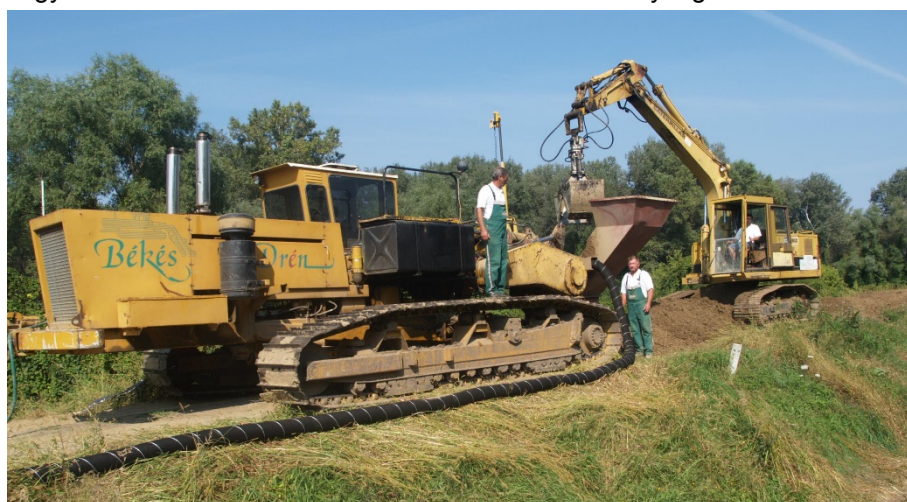
13-48. kép. Megelőző védekezés, szivárgó (drén) építése gépi technológiával a töltés mentett oldalába. A drén megszakítja a szivárgási utat, nem jut terhelés a mentett oldalra.
