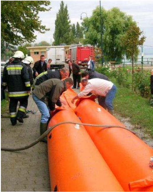
13-20. a. kép. Mobil árvízvédelmi gát, egy tömlős gát bemutatója
