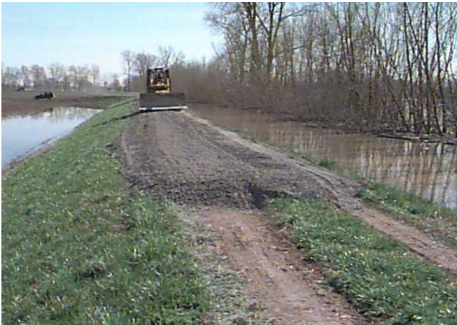
13-3. kép. Töltésfejelés teljes szelvényben az Egyesült Államokban, alighanem elfelejtettek lehumuszosítani. Ez a munka elég lassan halad, mert a dózer és a szállító jármű nem tudja kikerülni egymást a koronán. A talaj durva szemcséjűnek, túlságosan magas vízáteresztő-képességűnek tűnik, és ne feledjük, hogy dózerrel nem lehet tömöríteni!
