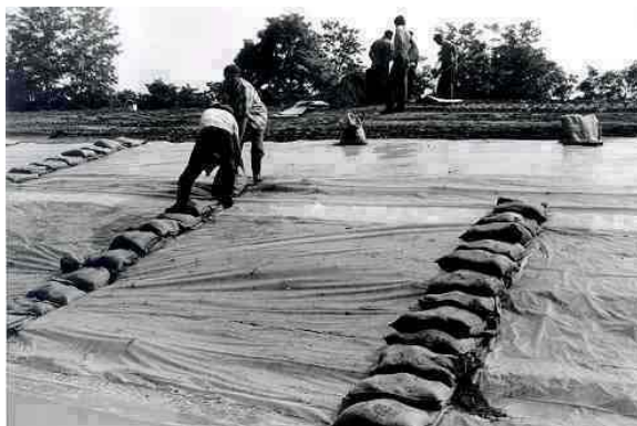
13-38. kép. Rézsűburkolat épülő fólia védelemmel.
