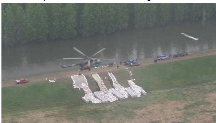
13-139. kép. Védelmi anyag szállítása a Kútréti II. suvadásnál.
