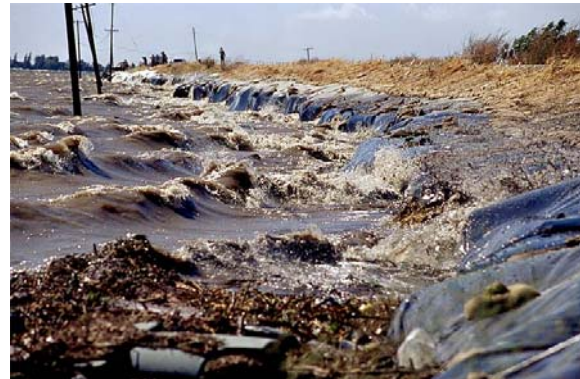
13-37. kép. Földrézsű hullámvédelve geotextíliával, előtérben az összegyűlt katré.
