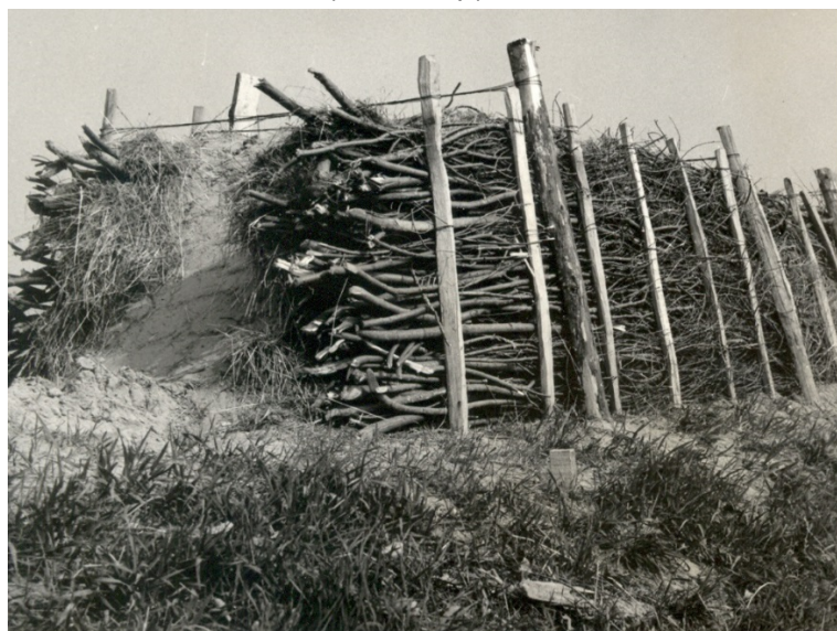
13-13. kép. Jászolgát rőzse borítással egy árvízvédelmi gyakorlaton.
