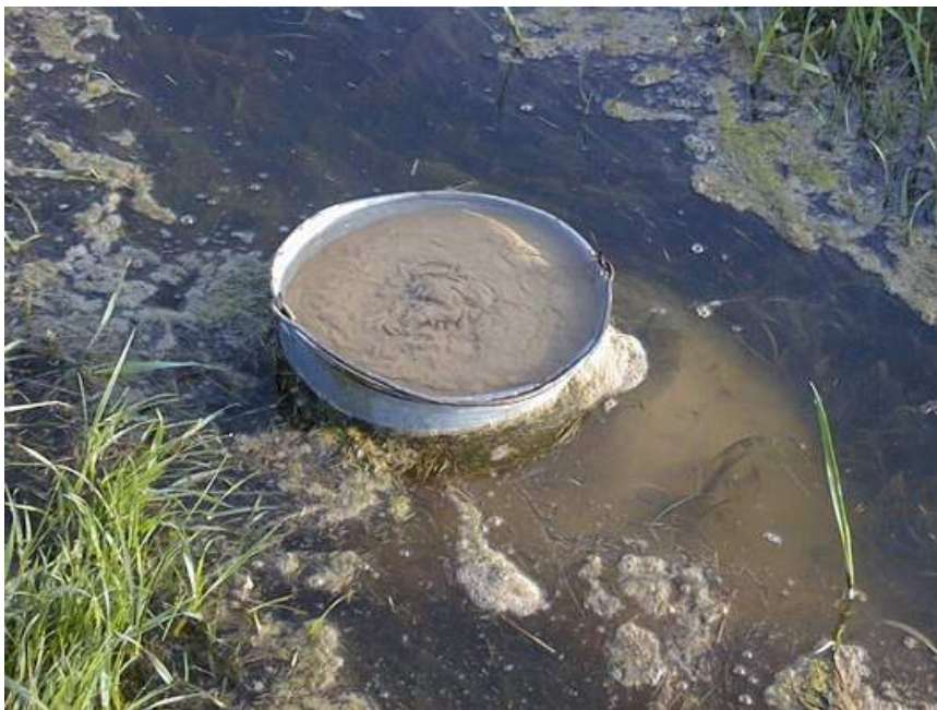
13-93. kép. Buzgár elfogás vödörrel (nem jó megoldás).
