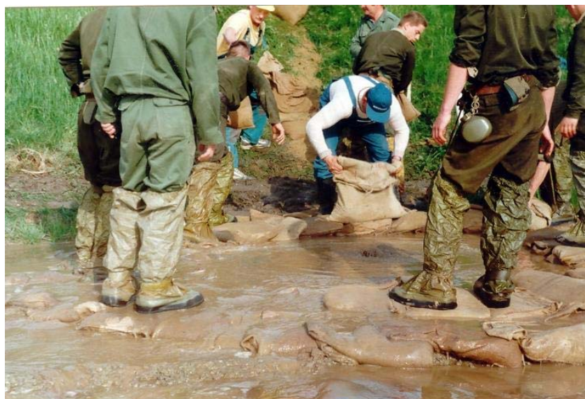
13-94. kép. A védekezés kezdete a tiszasasi buzgárnál.
