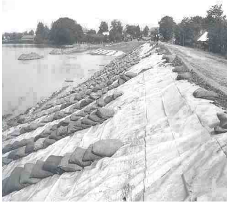
13-34. kép. Rézsű hullámvédelve geotextíliával.
