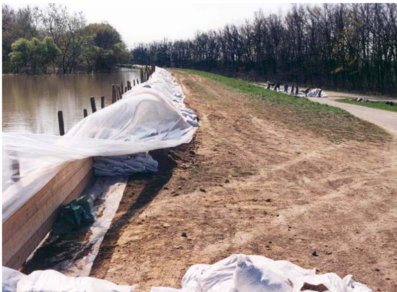
13-11. kép. Négy palló magasságú nyúlgát épül 2000-ben Tiszasülynél.
