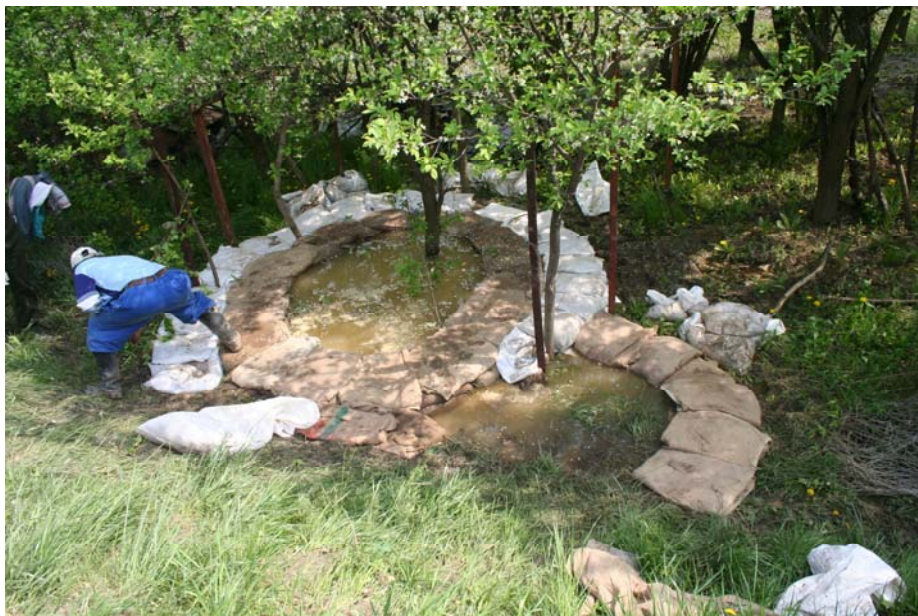
13-96. kép. A gát lábánál a szabadon hagyandó sáv szélessége 10 méter. Ezen belül sem épület, sem fa nem lehet. A belterületen a töltéslábhhoz telepített fák egyrészt akadályozzák a védekezést, másrészt árvízi jelenségek forrásai lehetnek.
