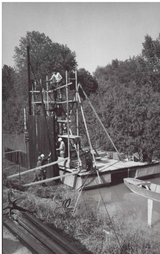
13-51. kép. Úszótagról szádlemez verés a gát vízoldalán az 1970. évi árvíznél.
