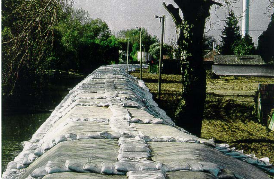
13-16. kép. Árvízvédelmi fal magasztása Szolnokon 2000-ben.
