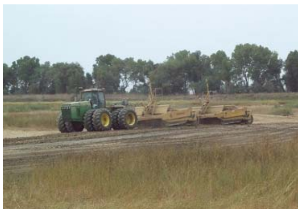
5–17. kép. Töltésépítés földtolóval és földnyesővel
