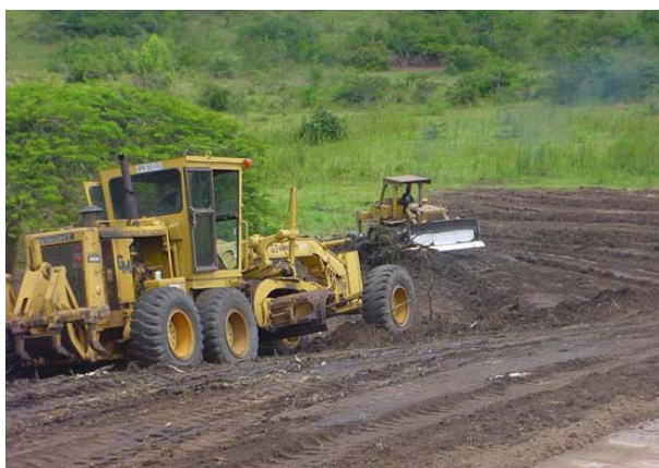
5–17. kép. Töltésépítés földtolóval és földnyesővel
