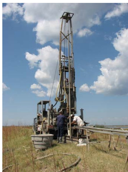
5–16. kép. Geotechnikai feltáró fúrás a gát koronáján
