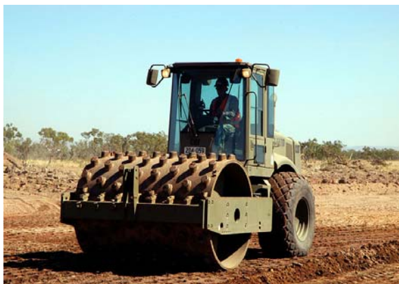
5–19. kép. Tömörítőgépek töltés építésépítésnél.
