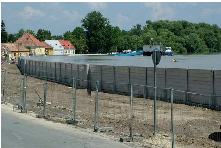
5–2. kép. Jól vizsgázott a 2013. évi árvíznél a már elkészült, át nem adott, Magyarország első mobil árvízvédelmi fala Szentendrén. Az 1,8 méter magas fal 333 méter hosszon védte a várost a mértékadó árvíznél magasabb vízzel szemben.
