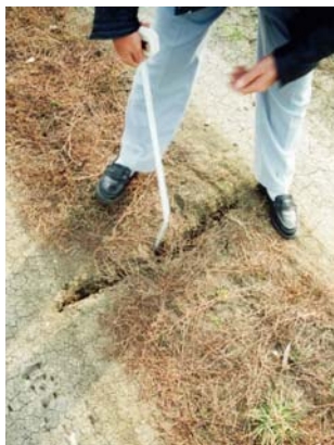
5–11. kép. Keresztirányú repedés a Zagyva bp. Töltésén, Jásztelek alatt (KÖTIVIZIG, 1991)
