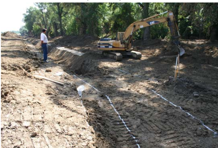
5–18. kép. Agyagék kitűzése a terepen, fentebb a profil kanállal elkészített munkagödör
