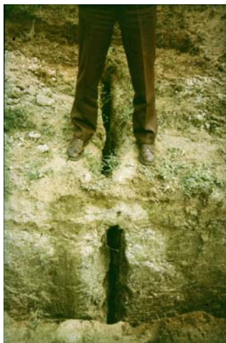
5–9. kép. Hosszirányú töltés-repedés a Kettős-Körös bp. töltésében a sarkadi híd alatt (KÖRVIZIG, 1989)
