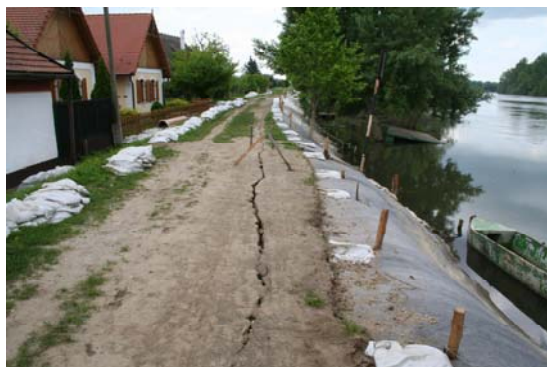
5–14. kép. Duzzadási repedés Vezseny északi részét védő alacsony gát koronáján (KÖTIVIZIG, 2006).
