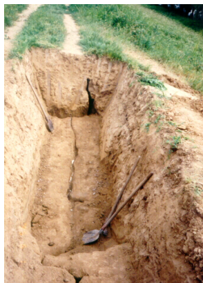
5–12. kép. Hosszirányú repedés egy Körös töltésben (KÖRVIZIG, 1993)
