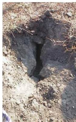
5–7. kép. Zsugorodási repedés a Zagyva jp. töltésében (KÖTIVIZIG, 1991)
