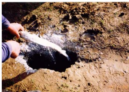
5–13. kép. Száradási repedés meszes vízzel történő feltöltése (Zagyva jr., 1991)
