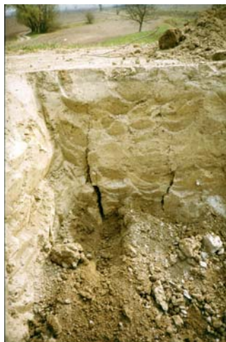
5–10. kép. Keresztirányú töltés-repedés a Duna jp. töltésében Karaszifoknál, a Sió torkolat felett (KÖDUVIZIG, 1991)
