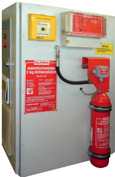
GLORIA Löschanlage KS 5 OS
