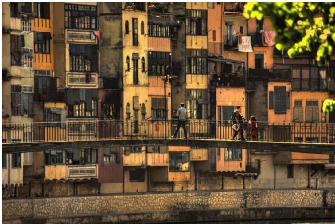
Figura 72: Les cases de l'Onyar amb el pont d'en Gómez al davant. Fotografia de l'any 2008. Ajuntament de Girona. CRDI (Josep Sánchez Rodríguez)
