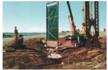
Kokkolan jätealueen ympärille maahan rakennettava 3,1 km pitkä eristysseinä valmistuu vuonna 2000.
