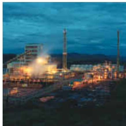
Outokummun ydintekniologia liekkisulatusprosessi otettiin käyttöön 50 vuotta sitten. Nikkelin suorasulatusprosessi, liekkisulatuksen uusi sovellus ilman erillistä konvertointivaihetta, on menestyksellisesti käytössä Fortalazan sulatolla Brasiliassa.
