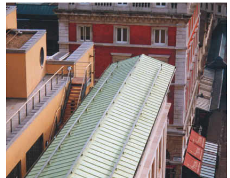
Outokummun kehittämää esipatinointimenetelmää, Nordic Greeniä, käytettiin Lontoon Covent Gardenin katon uudistuksessa vuonna 1999.
