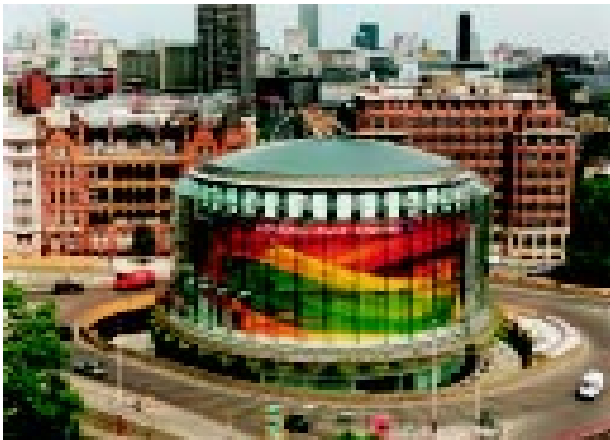
Lontoossa avatussa uudessa elokuvateatterissa on käytetty Gasellin Shine-pinnoitettua teräskatetta.
