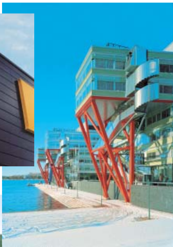
Vuoden teräsrakenteeksi Suomessa valittu Helsingin High Tech Center hyödyntää Rautaruukin terästä monessa muodossa.
