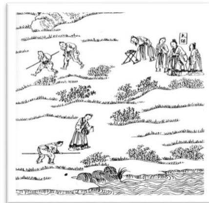
Fig.2 Replanteo de una vivienda china
