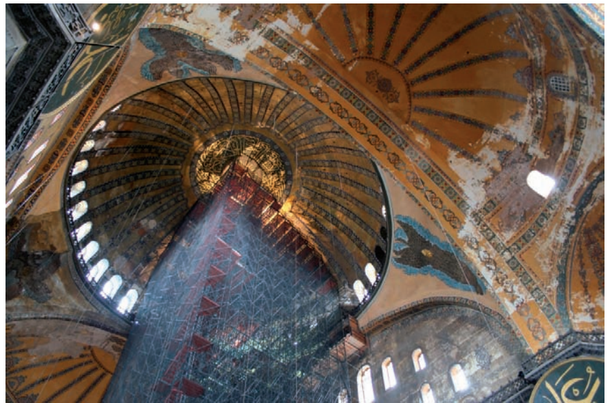
Abb. 5: Innenraum der Hagia Sophia mit Gerüststellung im Südost-Quadranten der Hauptkuppel
