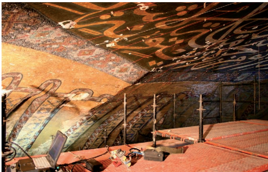
Abb. 13: Bruchkante zwischen den Bauteilen des 14. und 6. Jahrhunderts
