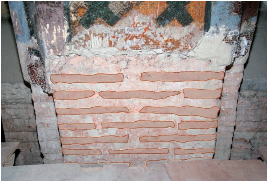
Abb. 17: Mauerwerkstruktur einer Rippe des 14. Jahrhunderts (Rippe 7)
