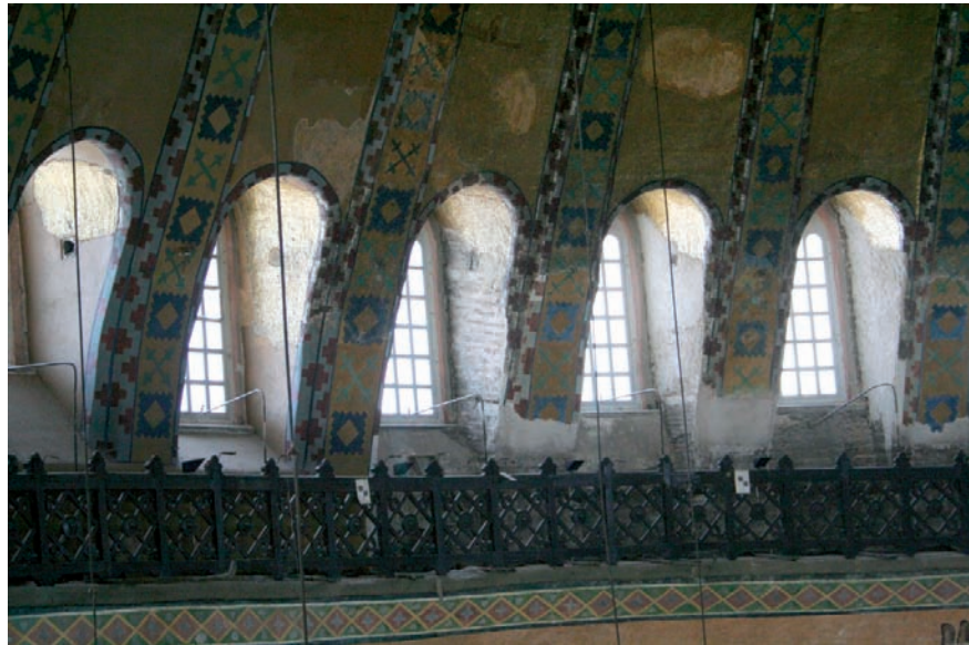
Abb. 19: Fensterpfeiler mit den Durchdringungen eines ehem. hölzernen Ringankers
