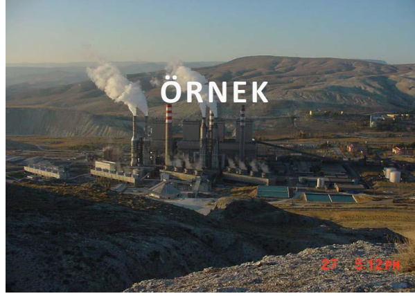
Şekil C.22 – (.....) Termik Santrali(Kaynak, yıl)
