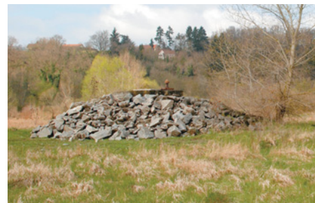
Captage d'eau potable dans la Réserve
