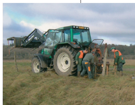
Enlèvement des clôtures inutiles
