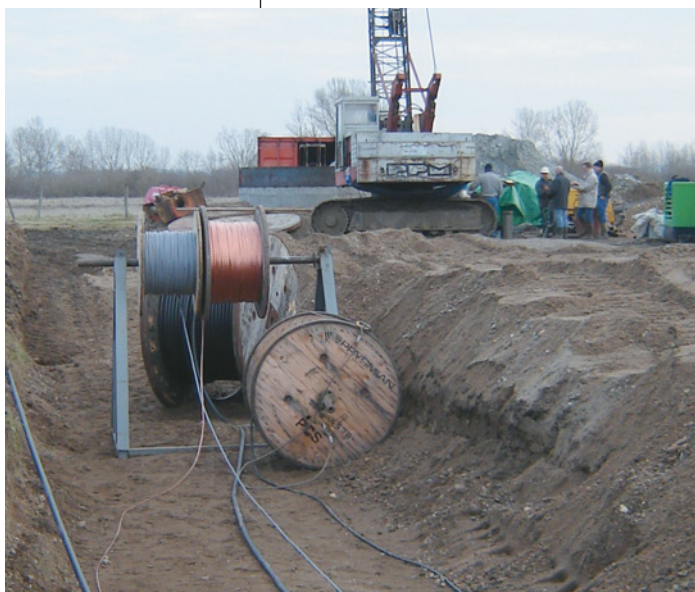
Pose de 700 m de câbles électriques et de canalisation
