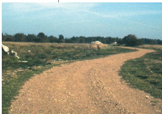
La nouvelle piste construite sans autorisation
