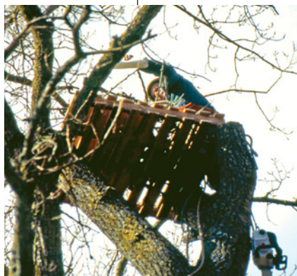
Installation d'une plate-forme pour balbuzards
