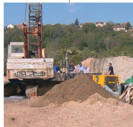
Une réunion de chantier
