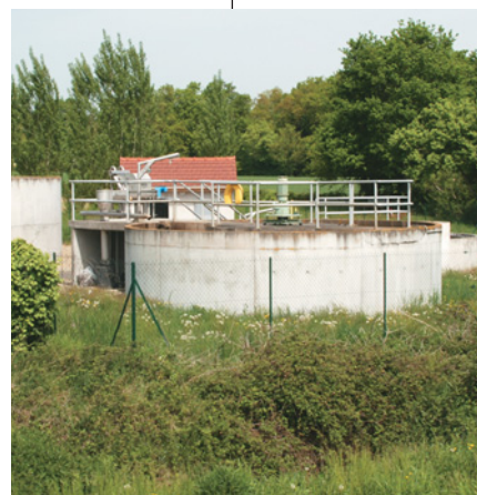
Nouvelle Station d'épuration
