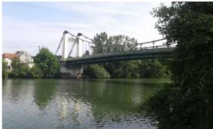
Pont de Saint Leu d'Esserent (Source : INGEO)
