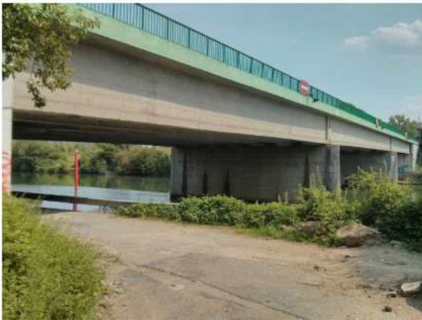
Pont de la D 301 de l'Isle Adam (source : INGEO)
