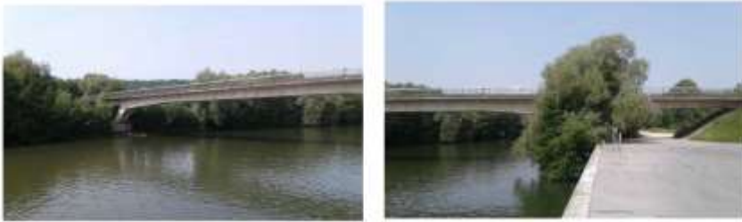
Pont près de la STEP sur Bruyères sur Oise (source : INGEO)
