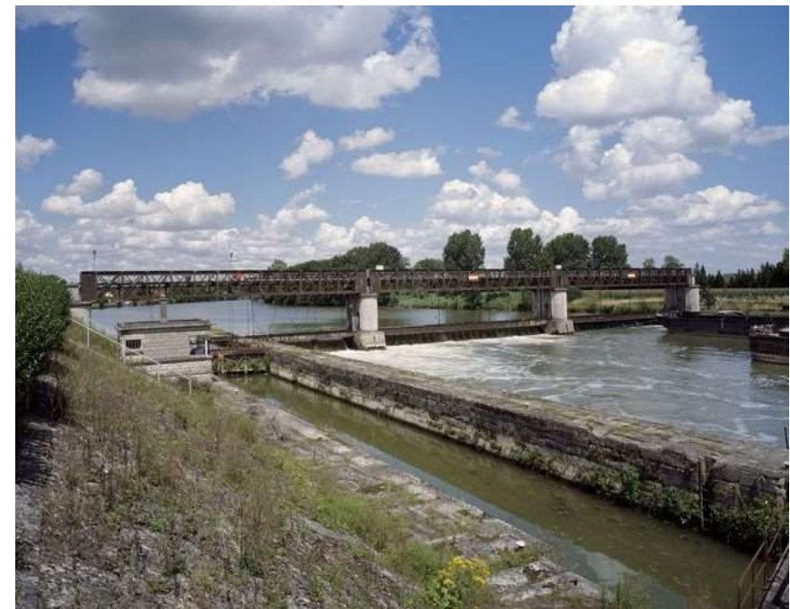
Exemple de barrage de type Derome (source inventaire des Hauts de France)
