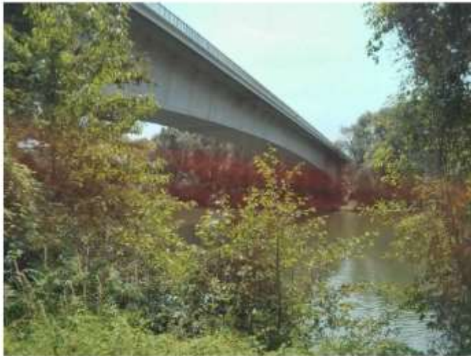
Pont Bernes sur Oise (source : INGEO)
