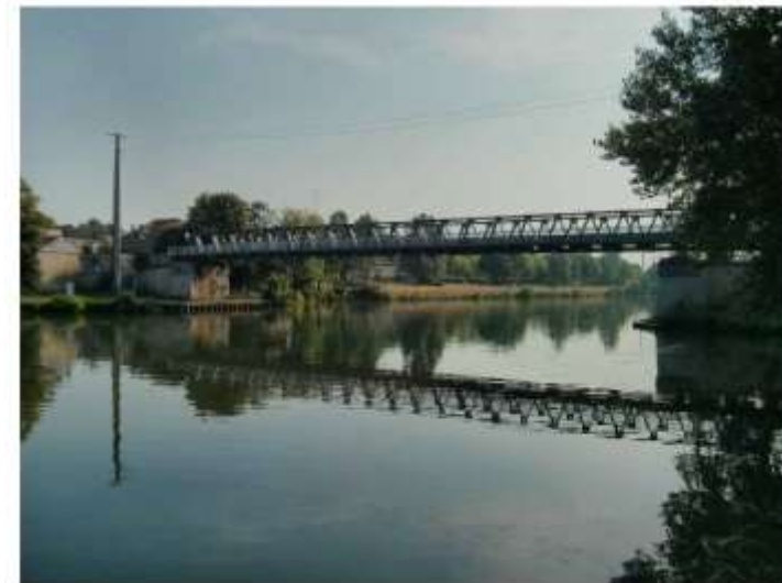
Pont Précy sur Oise (Source : INGEO)
