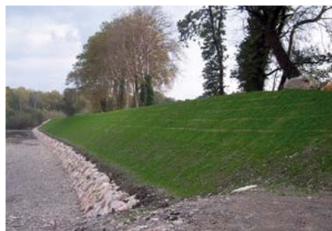
Confortement de la digue de Peyrevert à Noves (13)
