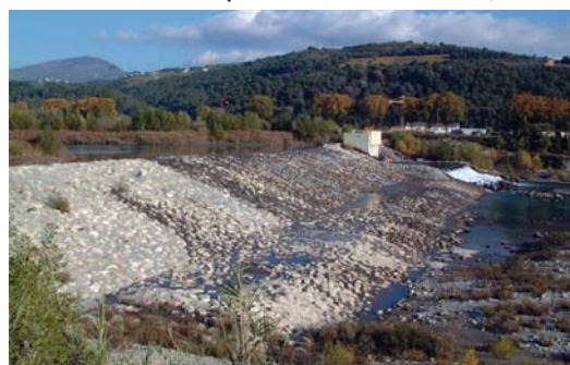
Le seuil 4 le plus aval, qui sera abaissé dans quelques dizaines d'années.
