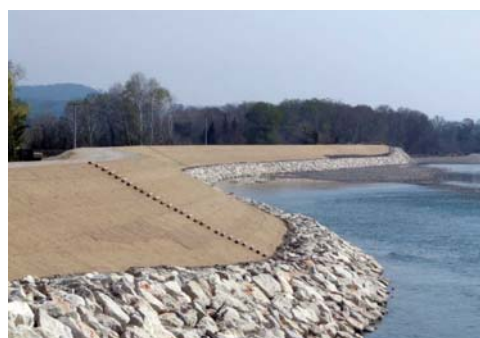
Digue reconstruite à Lauris, mise en eau du chenal.
