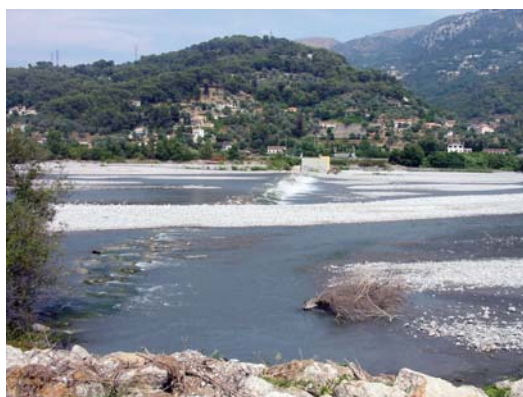
Le seuil 10 à l'amont qui va être abaissé en 2009-2010.
