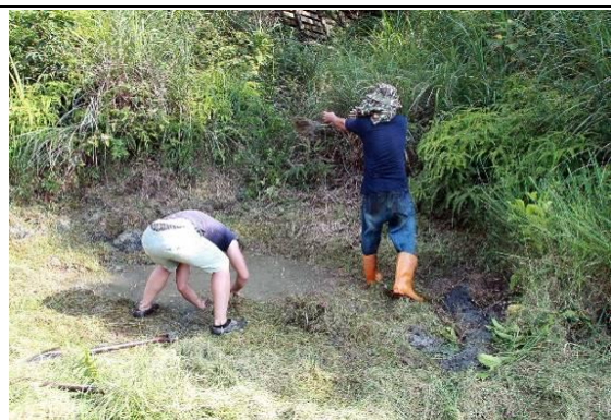
照片 13：挖掘蓄水池以儲水
