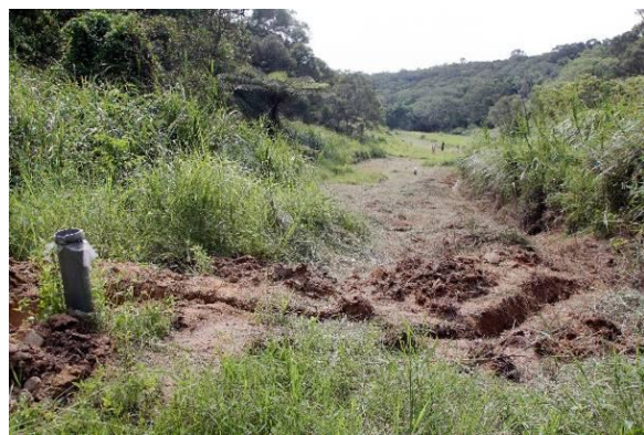
照片 12：106 年在崩坍土石下方挖一人工溝渠以導水
