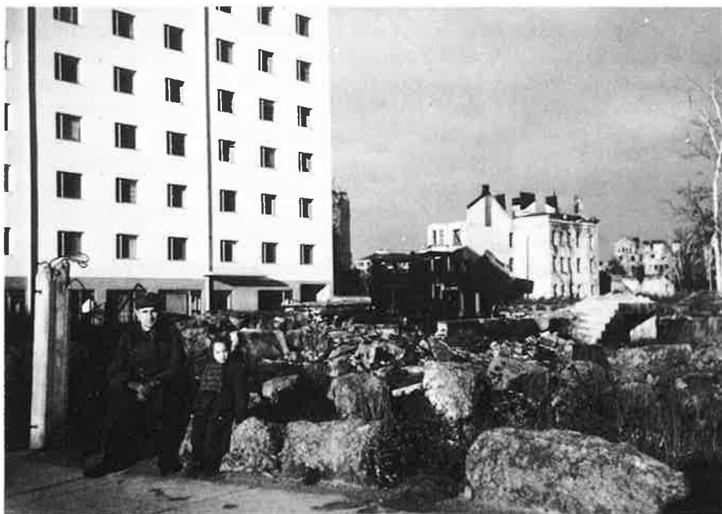
Sanomalehti Maakansan kirjapainon rauniot ja painokone. Vasemmalla korjattu As. Oy. Brahenlinnan talo. Valok. marraskuussa 1942 Elsa Nissilä.
