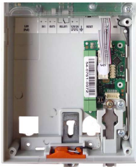
Bild: Montage des Schutzschalters
