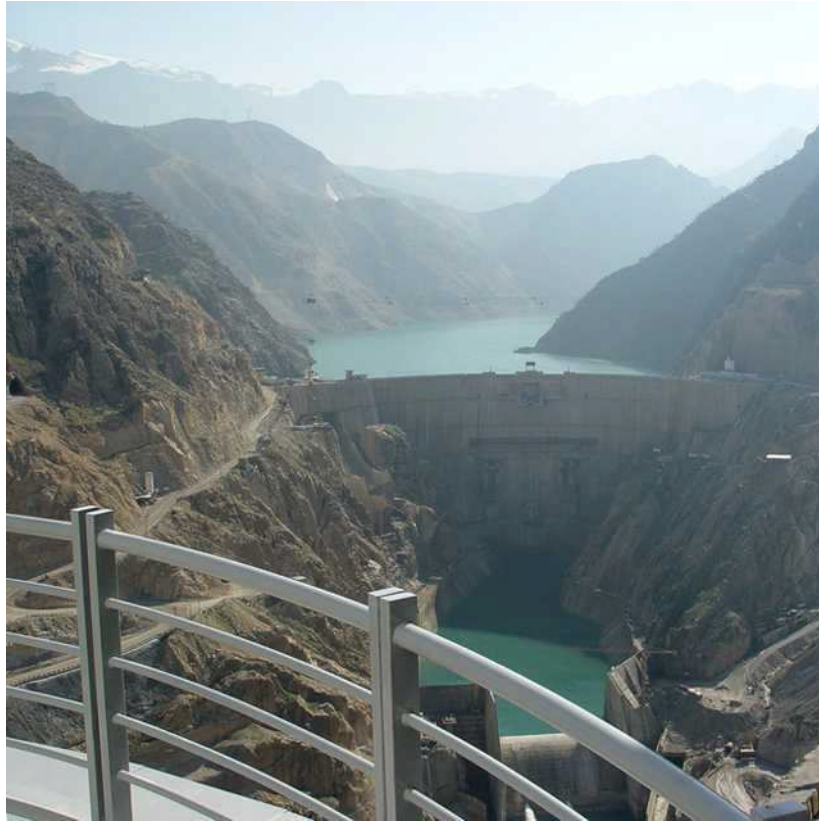
2.3. kép: Völgyzárógátas vízerőmű (Irán)
