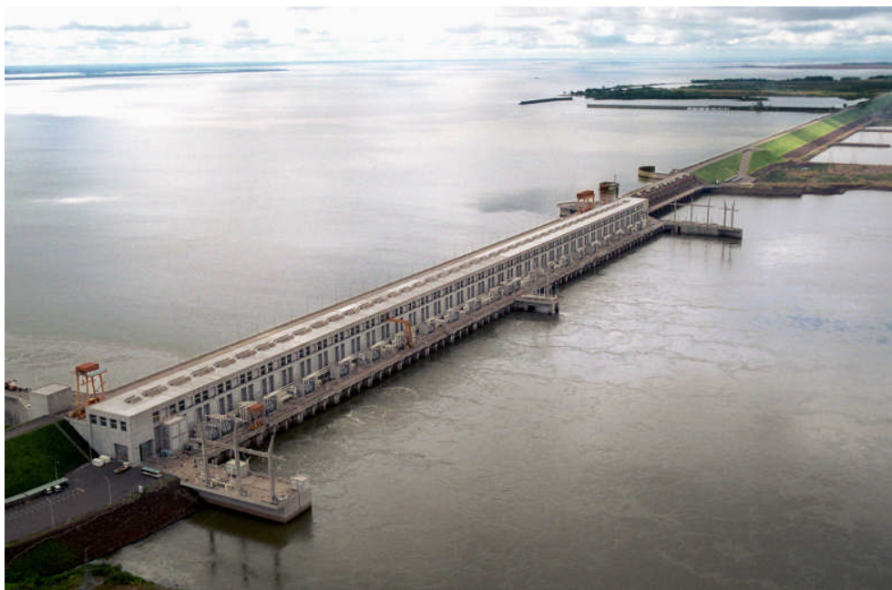
2.2. kép: Vízerőtelep, Argentína
