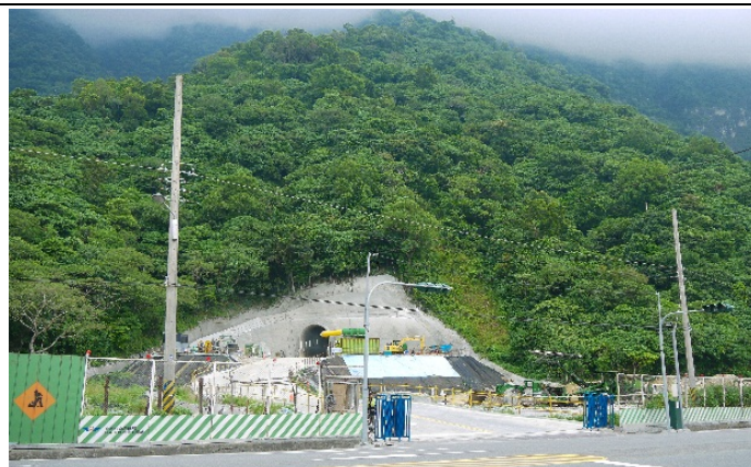
圖 5. 和仁和中北隧道 8 月間施工。
