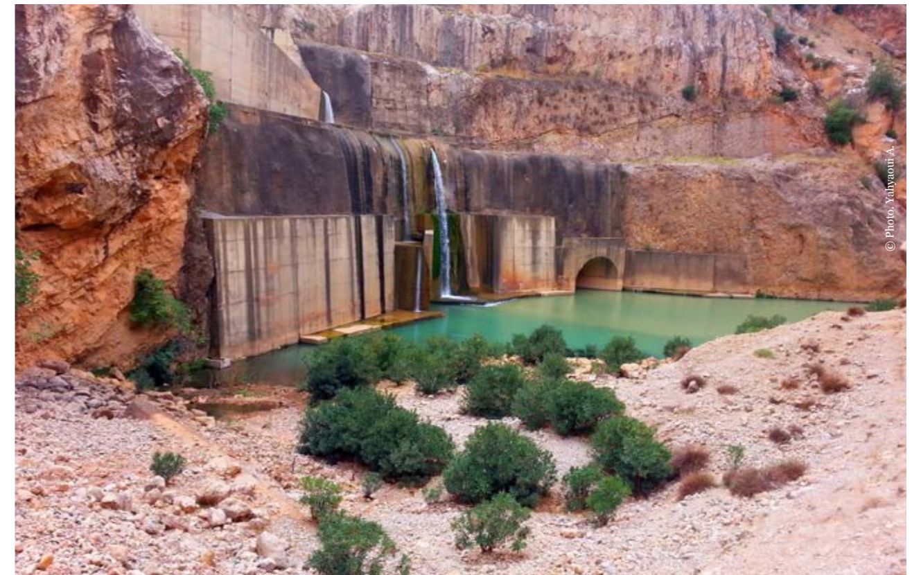
Barrage Allal El Fassi entravant la libre circulation des poissons
