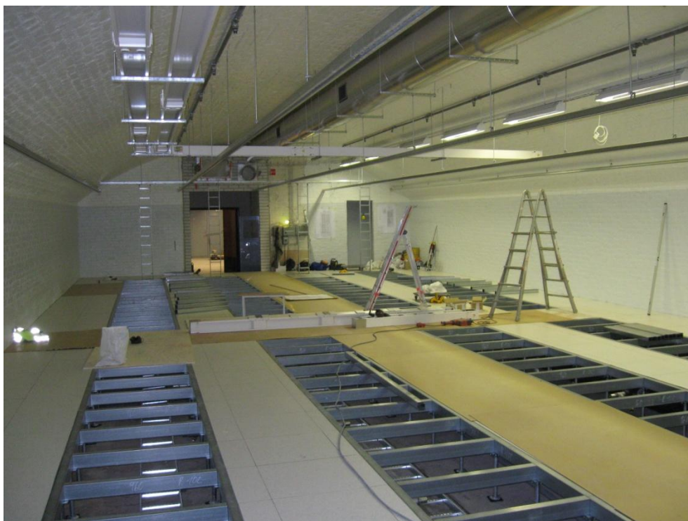
Kuva 8 Kanavuoren konesali rakennusvaiheessa (kesäkuu 2011)
