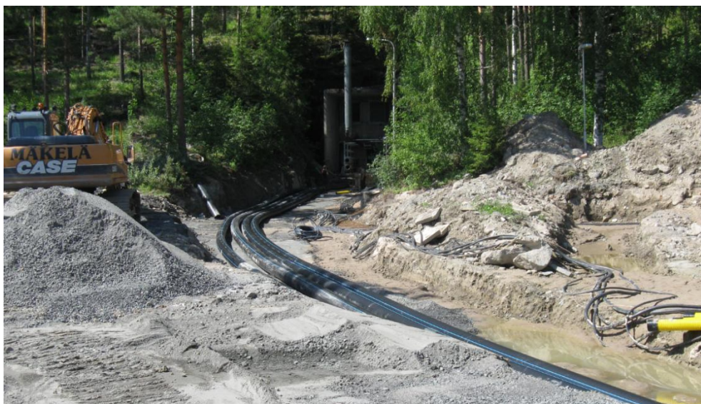
Kuva 9 Jäähdytysputkikaivanto piha-alueella (kesäkuu 2011)
