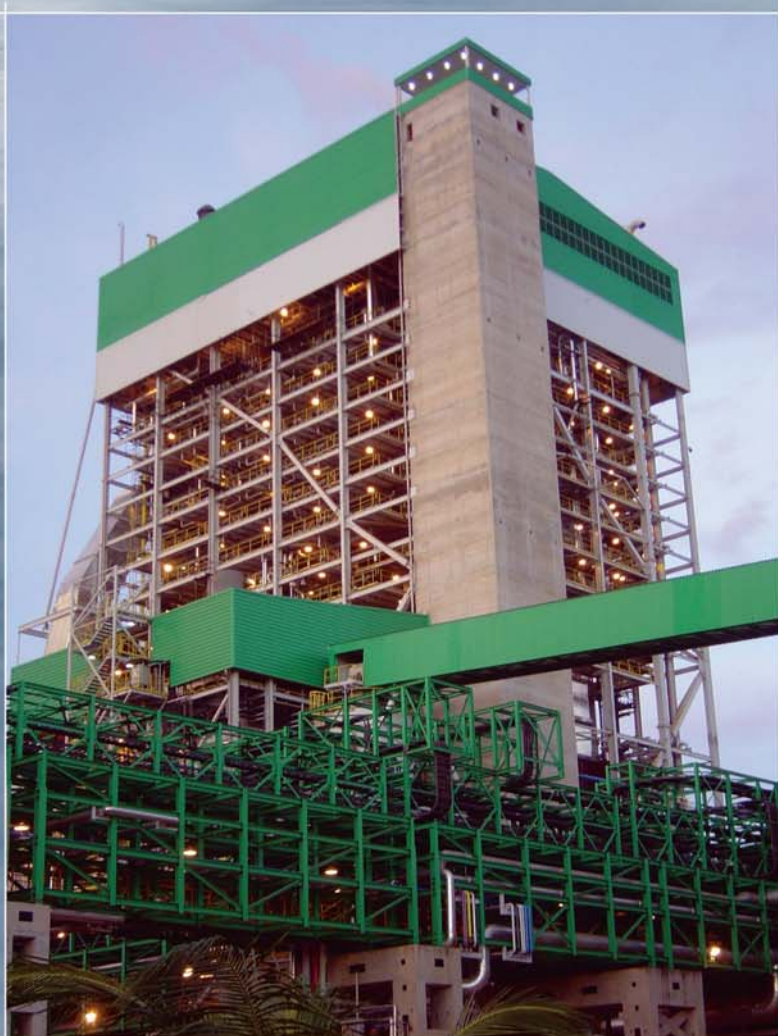
Obra: KVAERNER VERACEL Estrutura Metálica para Caldeira de Recuperação e Caldeira de Força Peso estimado: 3500 ton Local da Obra: Eunápolis/BA
