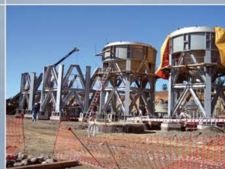
Obra: KVAERNER ITATA CELULOSE Estrutura Metálica para Sistema de Evaporação e Boiler Bottom, Vault Beams e Buckstays Peso Estimado: 1000 ton Local da Obra: Chile
