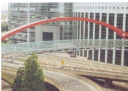
Figura 1 – Passarela Japão permite a ligação de duas áreas urbanas separadas por complexo viário de grande dimensão e intenso tráfego em La Defense, Paris.
