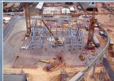
Obra: KVAERNER SUZANO (em execução) Estrutura Metálica para Caldeira de Recuperação Peso Estimado: 3800 ton Local da Obra: Mucuri/BA
