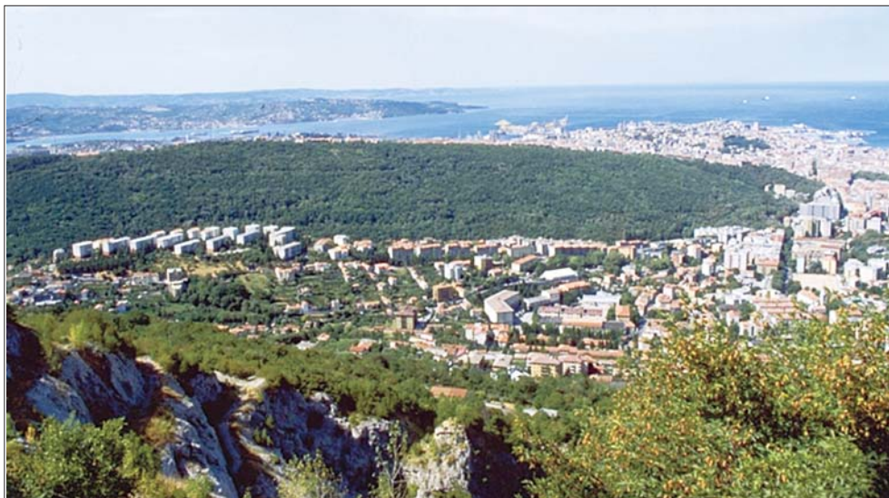
Fig. 2 – Il Bosco Farneto intorno agli anni 2000. Il punto più vicino al centro della città si trova a circa 40 m di altitudine, l’estremo nordorientale arriva ai 240 metri sul livello del mare, con esposizione prevalente NE.
