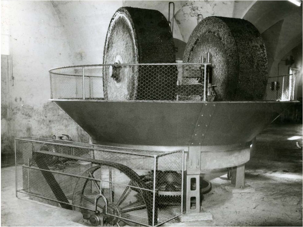
Figura 10. Frantoi a due macelli con movimento di sotto realizzato dalla Ditta Giuseppe Manna di Maglie, 1966 (©Archivio A. Monte).
