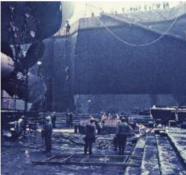
Sistemazione dei ponteggi per il distacco dell'elica
