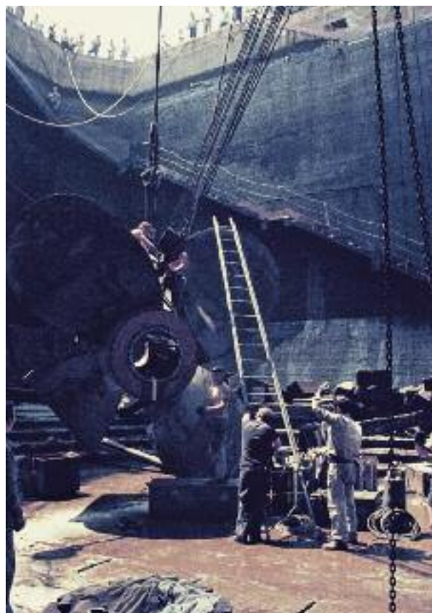
Si stacca il paranco e s'incoccia l'elica alla gru per trarla fuori dal bacino
