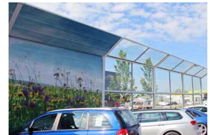
Printed noise barrier PLEXIGLAS® Soundstop GS CC Forster Metallbau Gesellschaft m.b.H. St. Pölten
