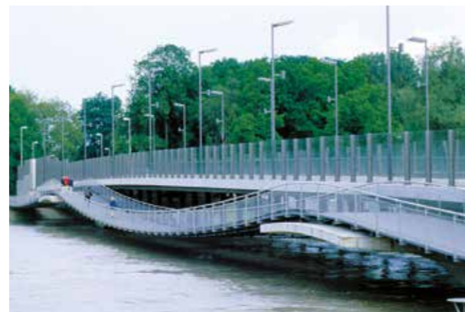
Noise barrier, Donaubrücke, Ingolstadt PLEXIGLAS® Soundstop GS CC Fa. Markus Kaiser
