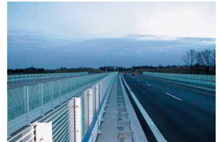
Noise barrier, Travequerung, Lübeck PLEXIGLAS® Soundstop GS CC Fa. Markus Kaiser
