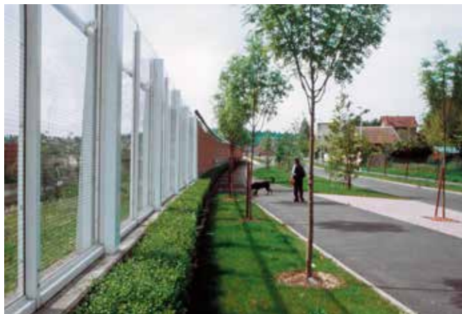
Noise barrier, Boulevard Intercommunal du Parisis PLEXIGLAS® Soundstop GS CC Direction Départementale de l'Équipement, Val d'Oise
