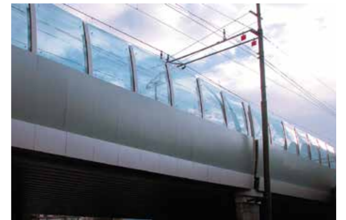
Noise barrier, Ponte Roma, Bolzano PLEXIGLAS® Soundstop GS CC FIP Industriale Spa, Selvazzano Dentro (Padova)
