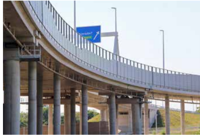
Noise barrier, A23, Knoten Inzerdorf PLEXIGLAS® Soundstop GS CC Forster Metallbau Gesellschaft m.b.H. Wien
