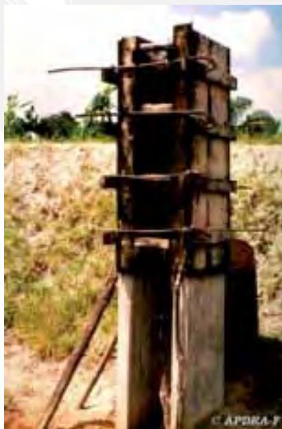
Photo I. Moine et moines (Guinée). À gauche : Le 1er étage et le moule ; À droite : Mise en place du 2ème étage [© APDRA-F] (CIRAD).
