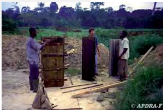
Photo I. Moine et moines (Guinée). À gauche : Le 1er étage et le moule ; À droite : Mise en place du 2ème étage [© APDRA-F] (CIRAD).
