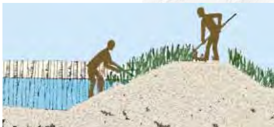
Figure 151. Nettoyage des digues.
