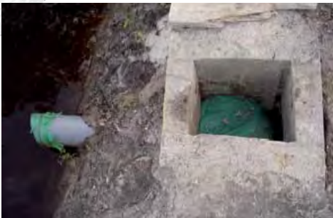
Photo H. Exemple de filtre mis en place à la prise d'eau d'un étang au Libéria [© Y. Fermon].
