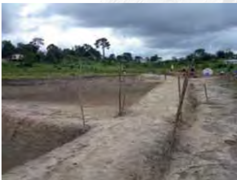
Photo E. Piquets lors de la construction des digues (Libéria) [© Y. Fermon].
