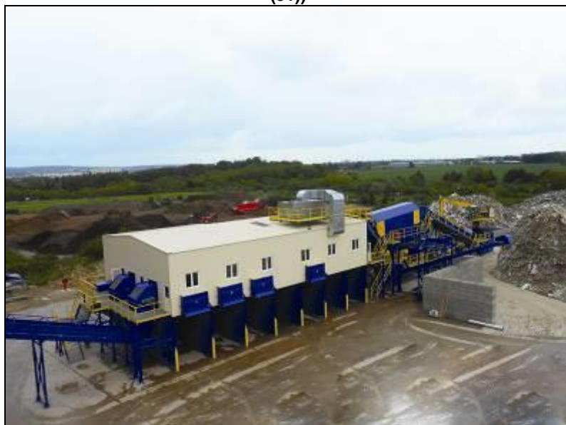
Figure 43 : Exemple de chaîne de tri de dernière génération spécifique aux déchets du BTP (« Paprec » - Wissous (91))
