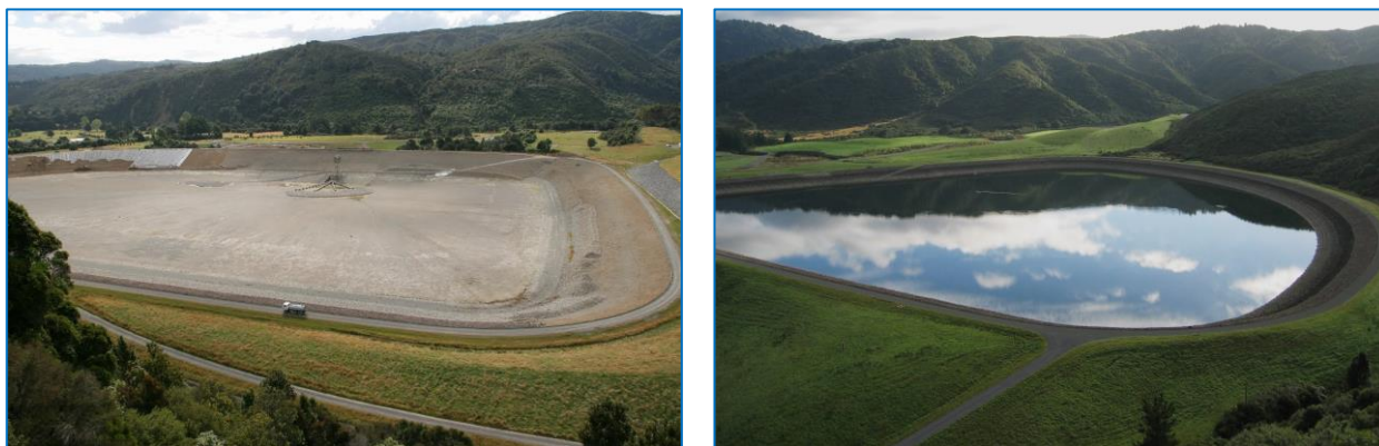
Figura 4: Estructuras de Aprovechamiento de Aguas Lluvias (Reservorios)
