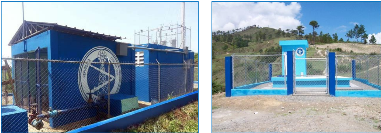
Figura 11: Obras de Agua con Instalación Eléctrica (izq.) y sin Instalación Eléctrica (der.)
