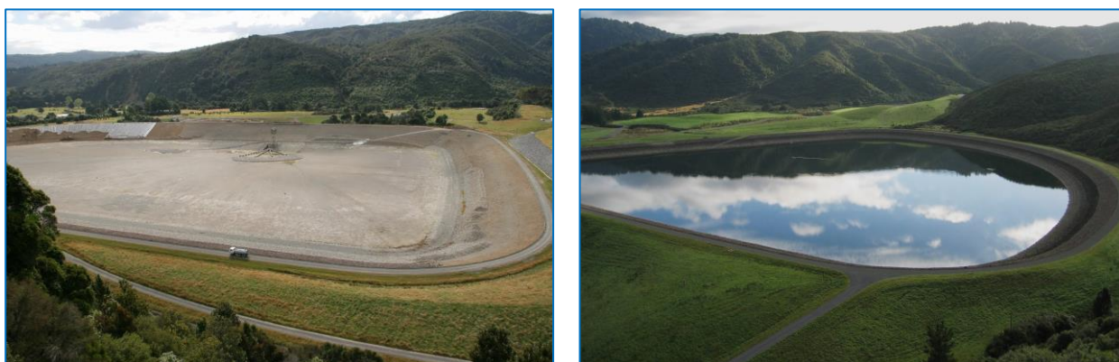
Figura 4: Estructuras de Aprovechamiento de Aguas Lluvias (Reservorios)
