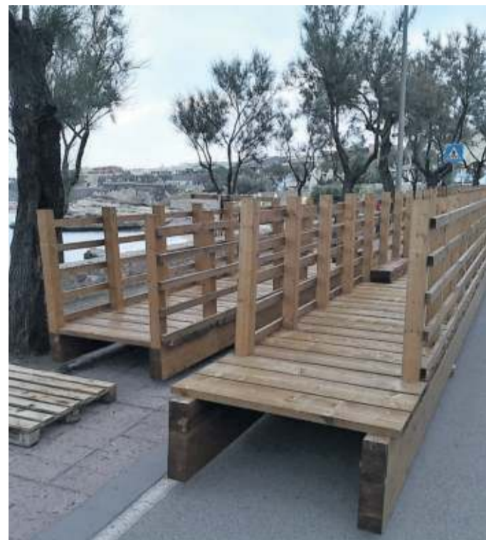
Le passerelle in legno in fase di posizionamento
