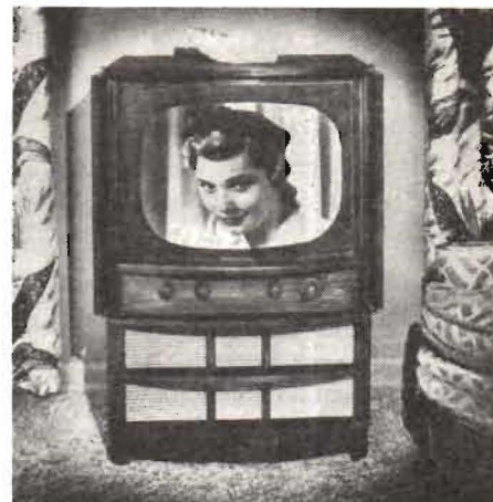
Fig. 1 Denna mottagare från Stromberg-Carlsson är utrustad med 19 rör+3 likriktarrör och bildrör. 12" högtalare. Skyddsglasets kan lätt borttagas och göras rent.
