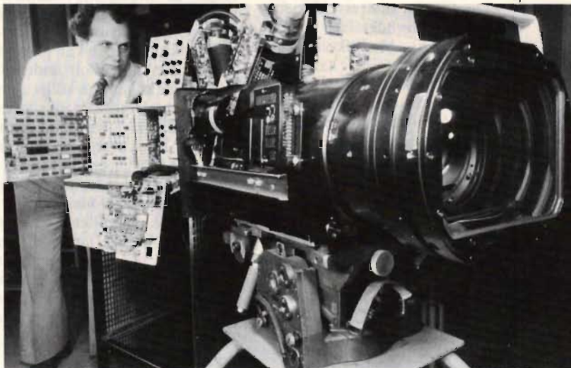
Fig 1. Den motorlösa, helt elektroniska och mikrodatorstyrda färg-tv-kameran från Marconi, vilken kan fjärrkontrolleras med helt automatisk uppsättning och inställning.
