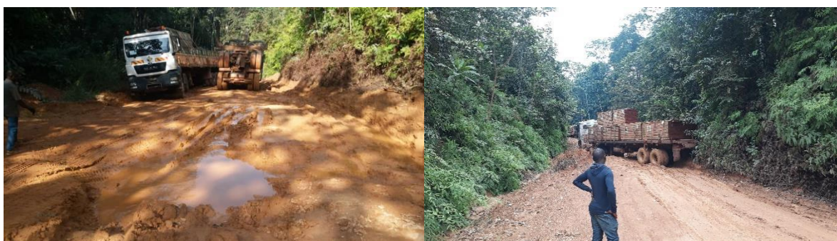
Figure 164 : Mauvais état de la route en saison des pluies
