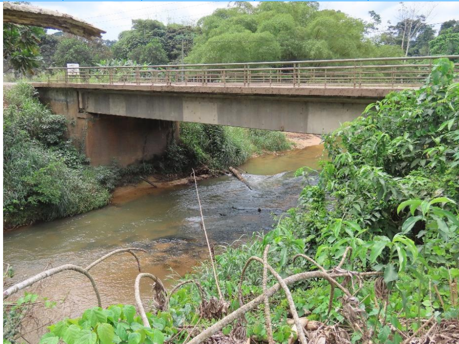
Figure 32 - Pont sur l'Agoula
