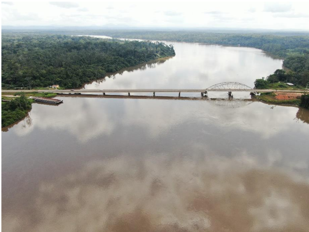
Figure 33 - Pont sur le Komo
