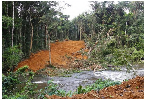
Site barrage, piste axe rive droite et axe rive gauche de chaque côté du Komo, pour le futur barrage
