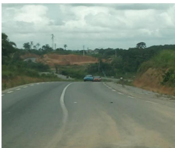
Route goudronnée qui traverse Anyama en direction d'Adzopé.
