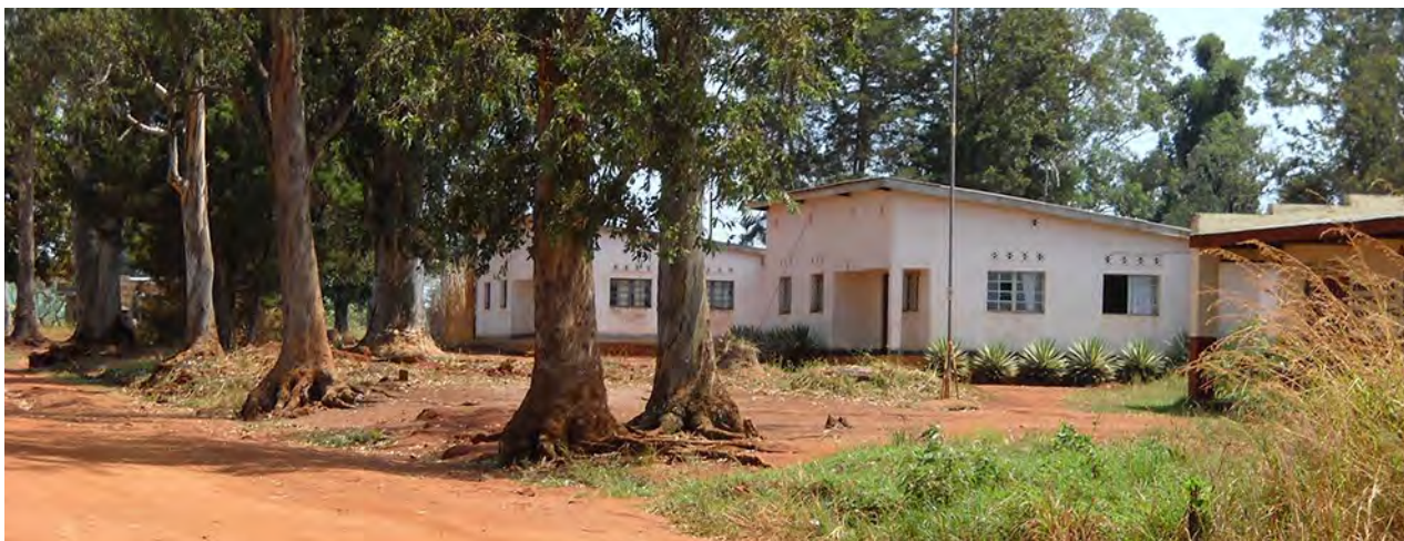
Bâtiment du bureau du Projet Ituri à Aru.
