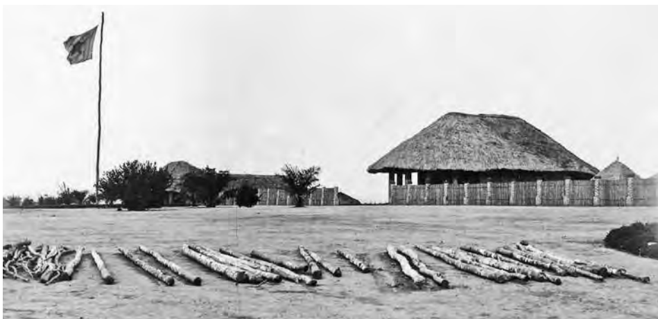
Le poste d'Irumu.
