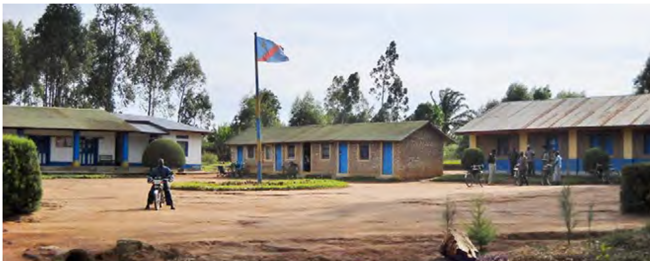
Bâtiment administratif de la chefferie Zaki, territoire d'Aru.
