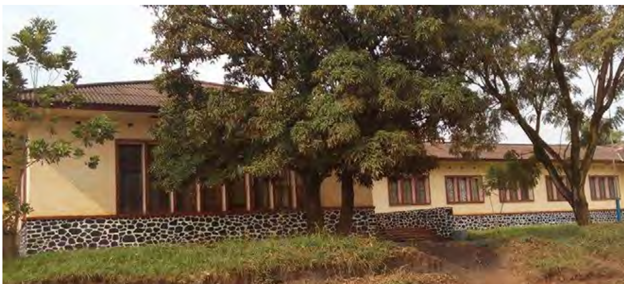
Bâtiment administratif du district de l'Ituri.
