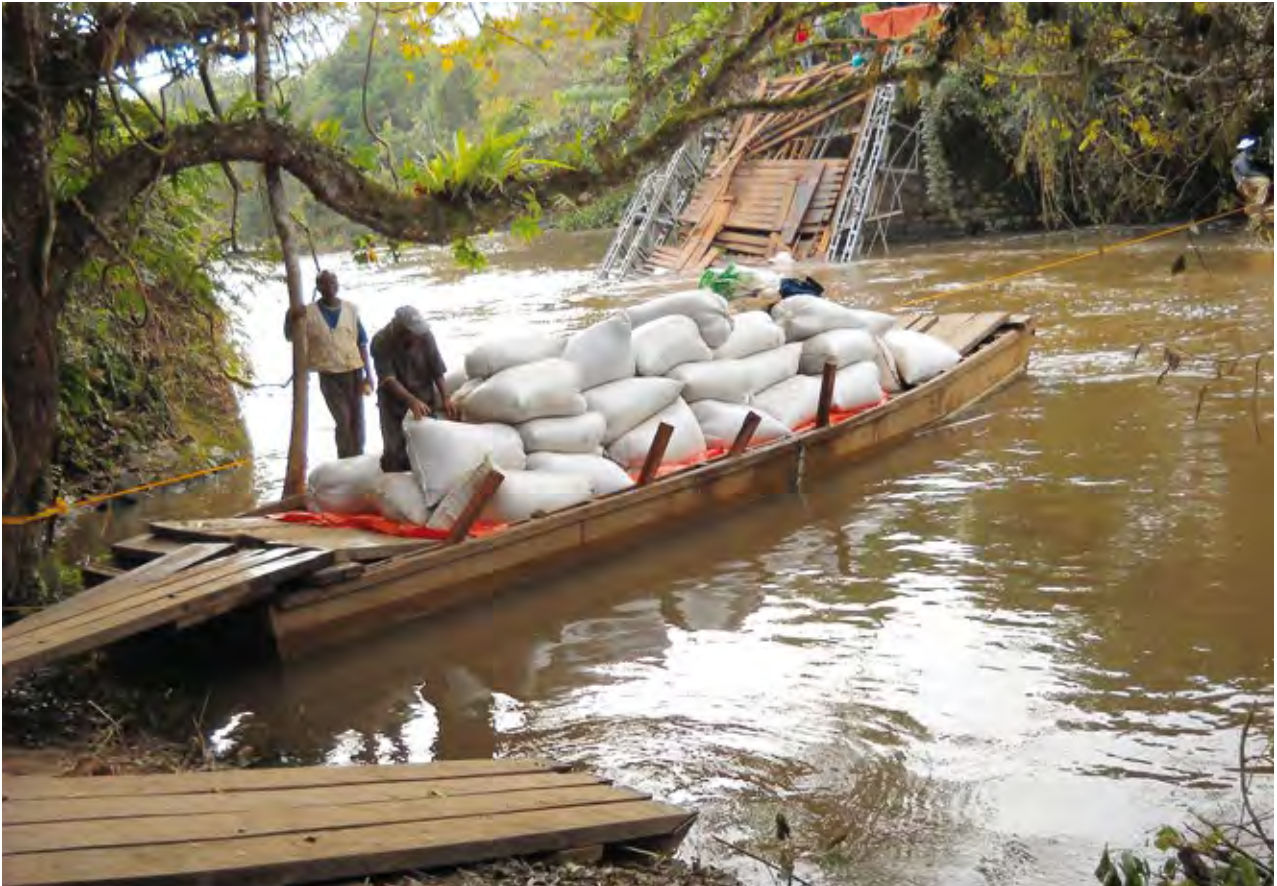
Reste du pont effondré et transport par barque.
