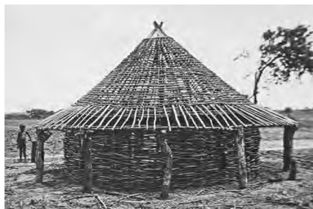
Construction d'une hutte chez les Lugbara à Esebi. (EP.0.0.5128, collection MRAC Tervuren ; photo R.F. Gérard, s.d.)
