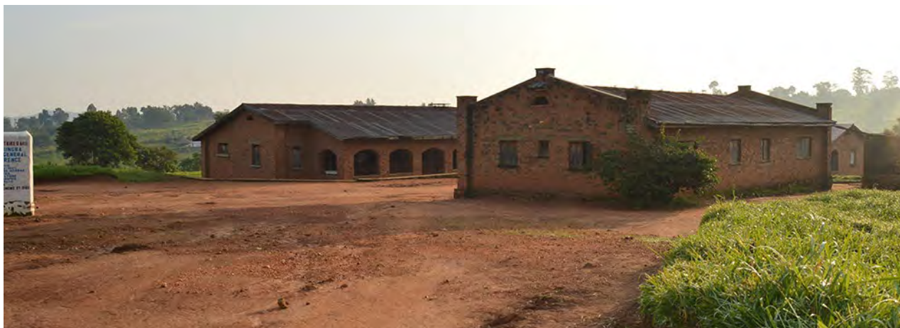
Bâtiments de l'HGR de la zone de santé rurale d'Aungba. (Archives familiales David Remo, juillet 2015.)
