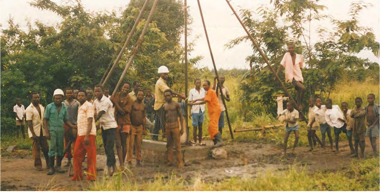
Dans la plaine de Kasenyi, forage du service hydrologique à la recherche d'une nappe aquifère. (Photo Mokili Mbuluyo, 1988.)
