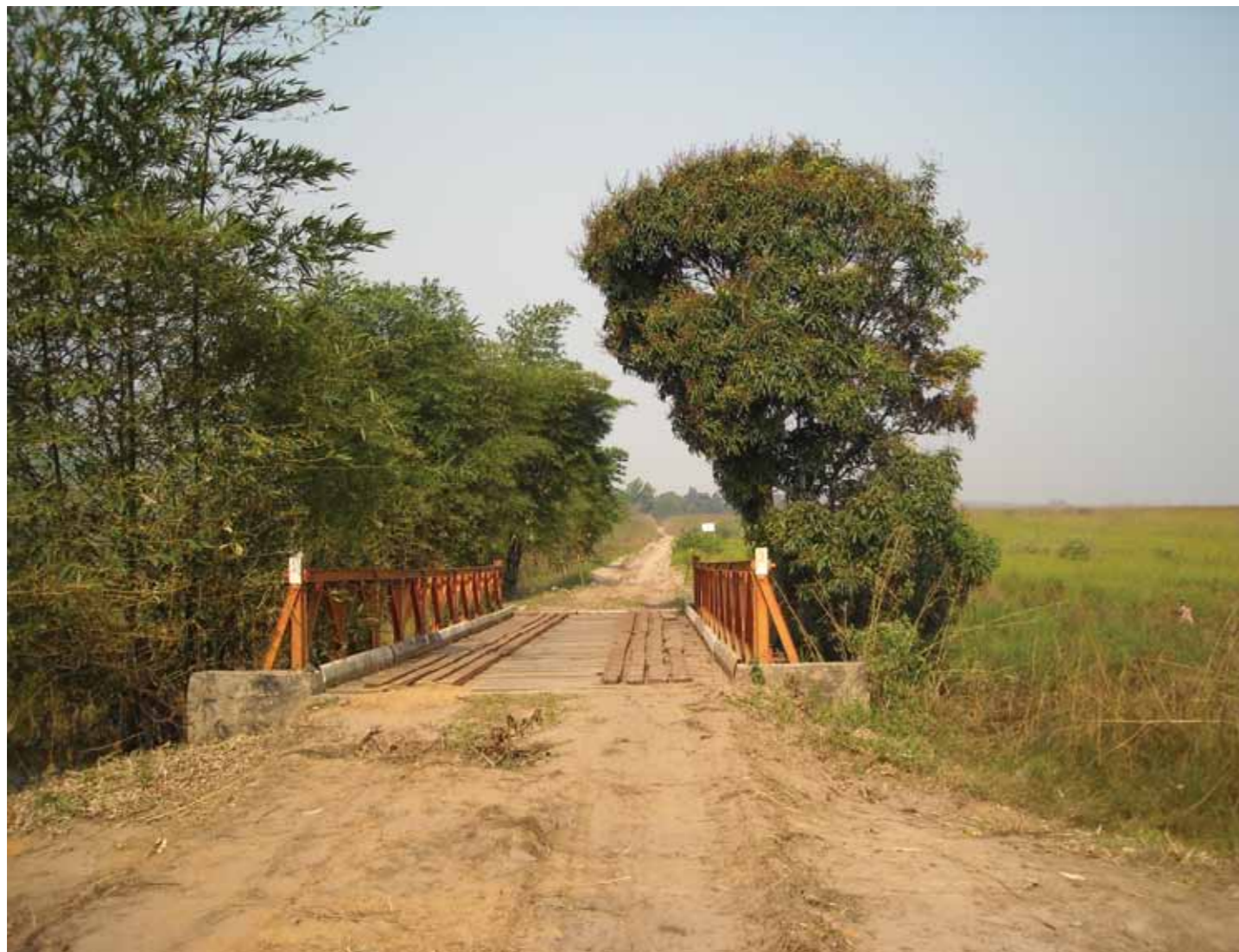
Ill.14.7. Pont sur la rivière Kandjanga, route Kaway-Kimbulungu. (Photo équipe locale, 2009.)
