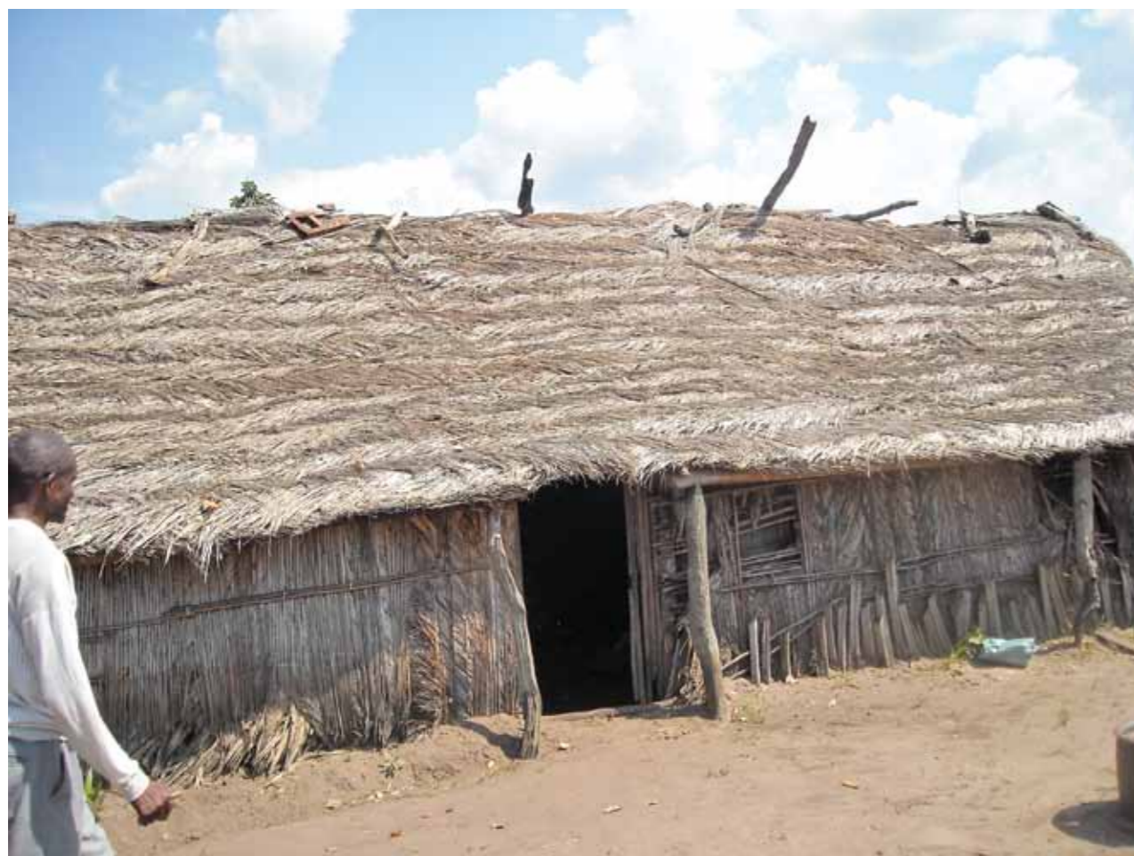
III. 15.2. Centre de santé de Biteko, zone de santé de Kenge. (Photo équipe locale, 2009.)
