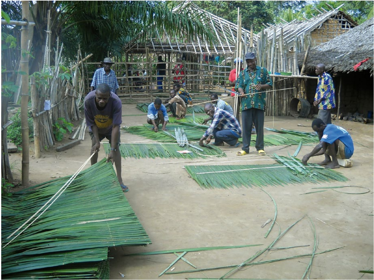
Fabrication de pailles pour la couverture des cases. (Photo équipe locale, 2009.)
