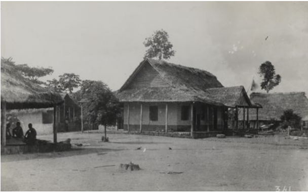
Le poste d'Umangi.
