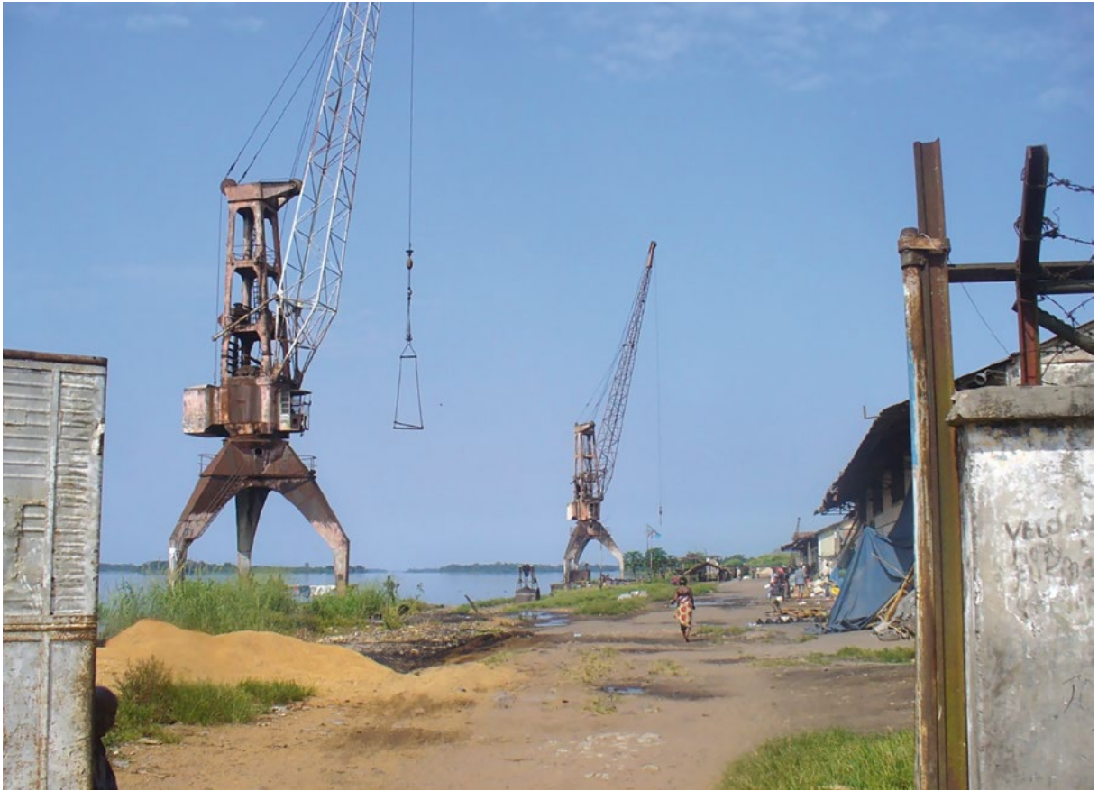
Grues de l'Onatra, Bumba. (Photo Antonio Lisuma, décembre 2010.)
