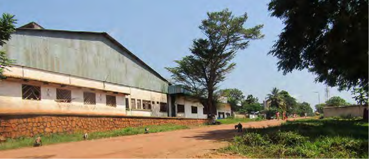
Flanc de l'ancien garage présidentiel à Gbado-Lite. Aujourd'hui, les locaux sont occupés par l'ISTM/Gbado-Lite, une école secondaire et un centre médical privé nommé « clinique Saint-Joseph ». (Photo équipe locale, novembre 2017.)
