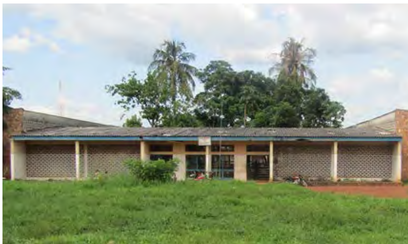
Ancien bâtiment de l'internat du collège de Gbado-Lite occupé par la Justice.
