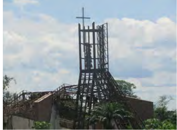
Vue rapprochée, la chapelle a perdu sa toiture. (Photo Daniel Gonzato, équipe locale, 2017.)
