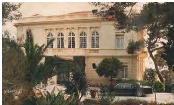
Vue extérieure de la résidence de Mobutu du cap Martin à Nice.
