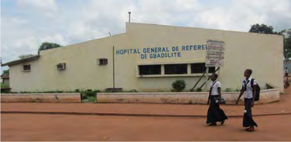
Une vue du bâtiment central de l'hôpital de référence de Gbado-Lite.
