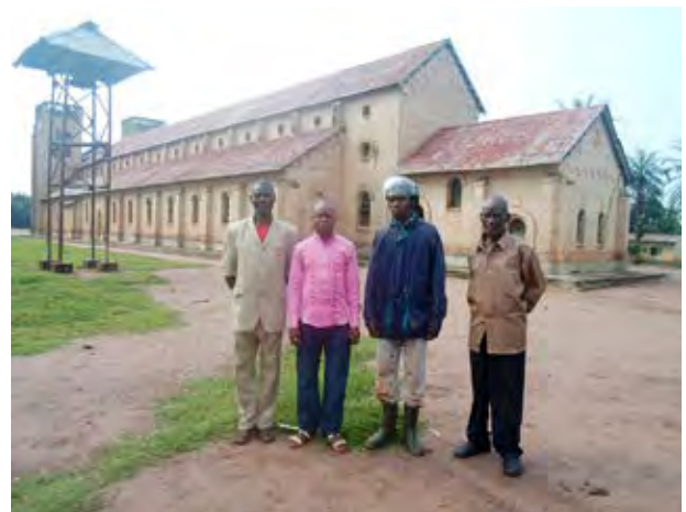
Ce même édifice vu à partir de l'arrière. Ici on voit que le clocher a été rajouté à l'extérieur, car l'ancien intégré à l'origine dans le bâtiment ne fonctionnant plus est devenu difficile à entretenir. (Photo équipe locale, 17 juillet 2015.)
