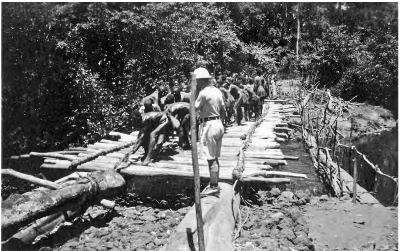
Construction de ponts sur la rivière Gini. (AP.0.1.5467, collection MRAC Tervuren ; photo H. Rosy, vers 1936 © MRAC Tervuren.)
