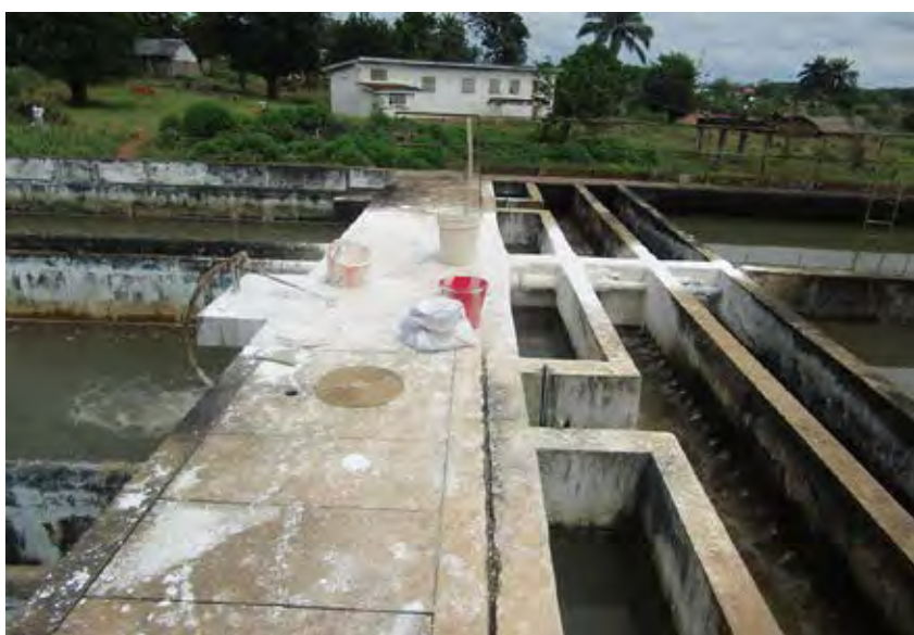
Bassins d'épuration et de traitement d'eau Regideso Gbado-Lite.
