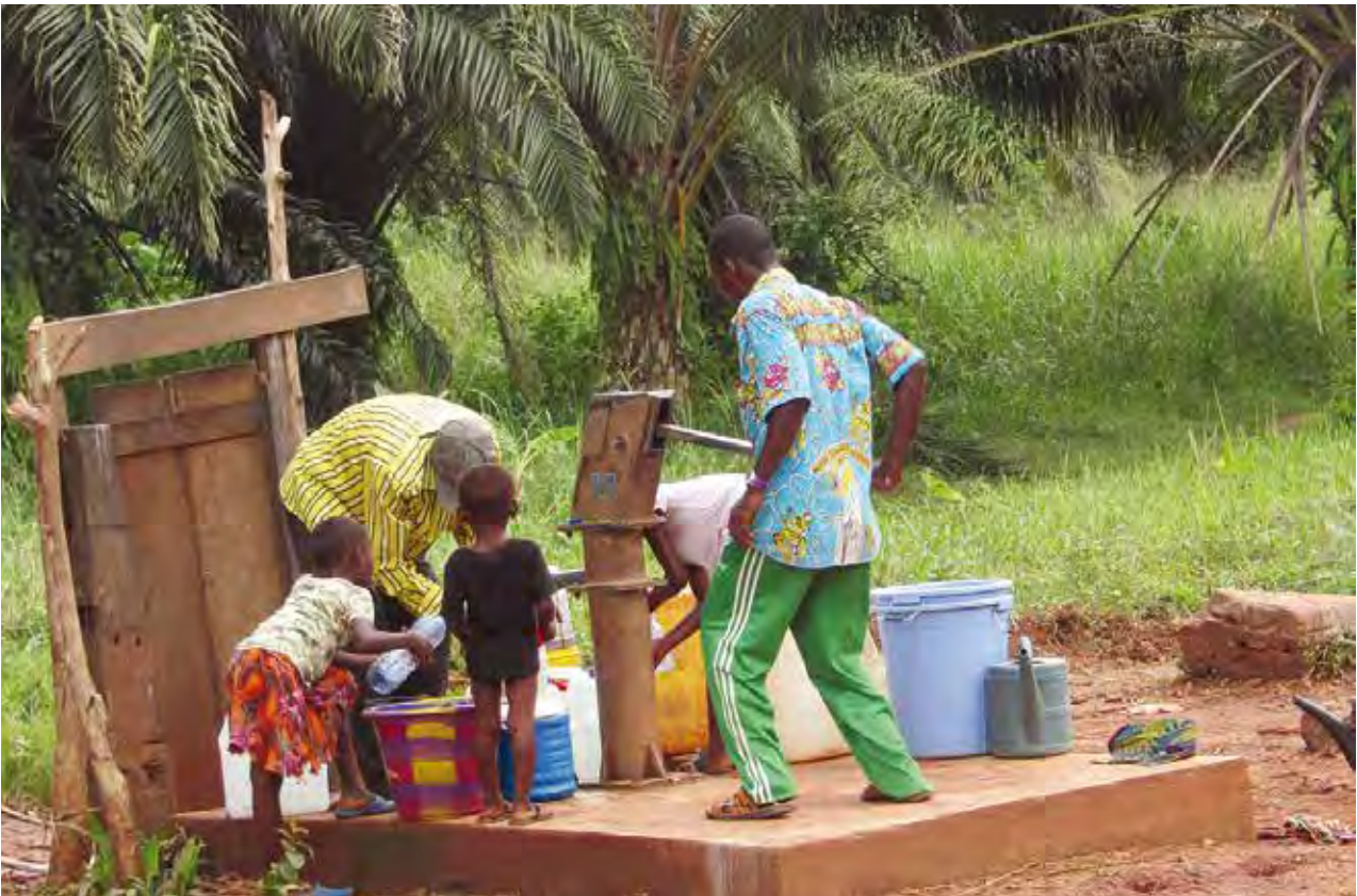
Un puits d'eau ARDA dans la commune de Molegbe à Gbado-Lite. (Photo Daniel Gonzato, équipe locale, 2017.)
