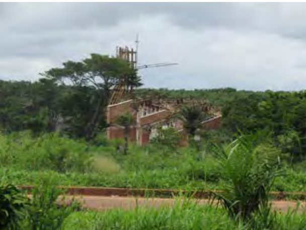
Vue rapprochée, la chapelle qui a perdu sa toiture porte toujours sa croix. Si ce terrain n'est pas encore envahi par de nouvelles constructions de particuliers, c'est à cause de son voisinage avec le camp des soldats. (Photo Espérant Mangi, équipe locale, 2018.)
