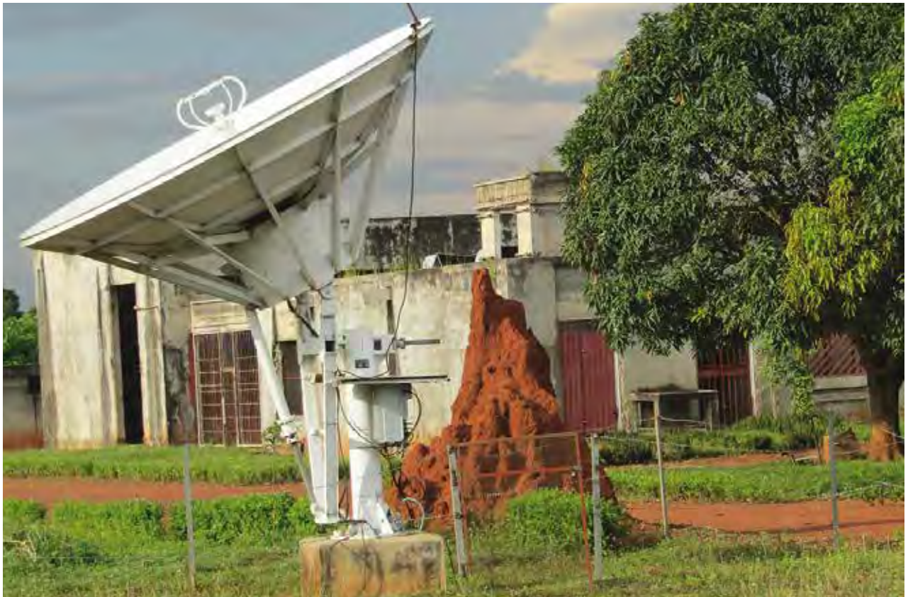
Un relais par satellite du contrôle de navigation aérienne à l'aéroport de Moanda à Gbado-Lite. (Photo Daniel Gonzato, équipe locale, 2017.)
