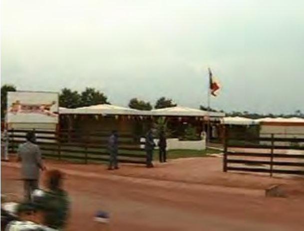
Vue extérieure du complexe scolaire Les Canetons en 1985. (Photo extraite du documentaire sur la visite au Zaïre du roi Baudouin en compagnie du couple Mobutu. Droits réservés.)
